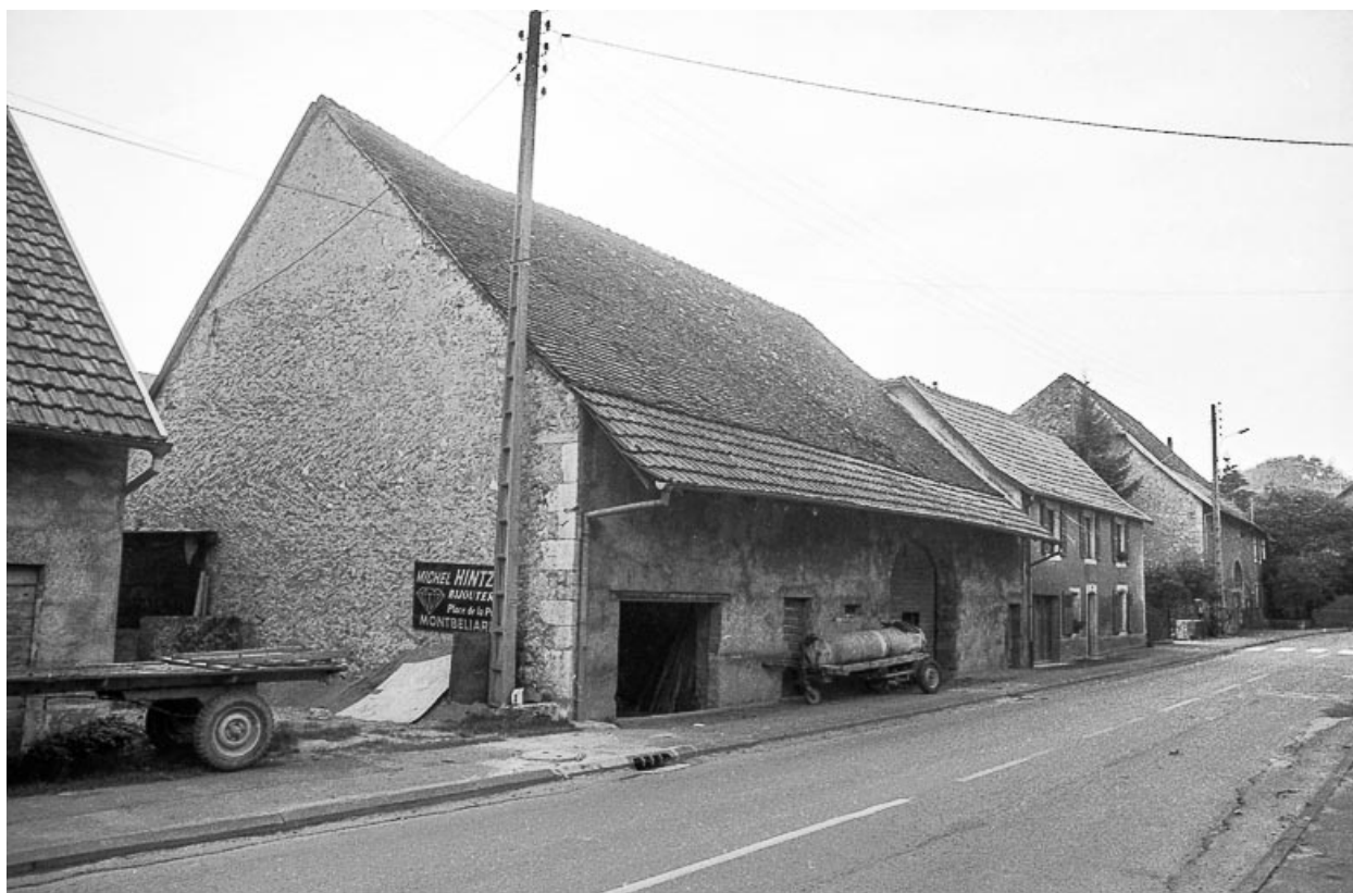
Ferme située rue de Courcelles.
