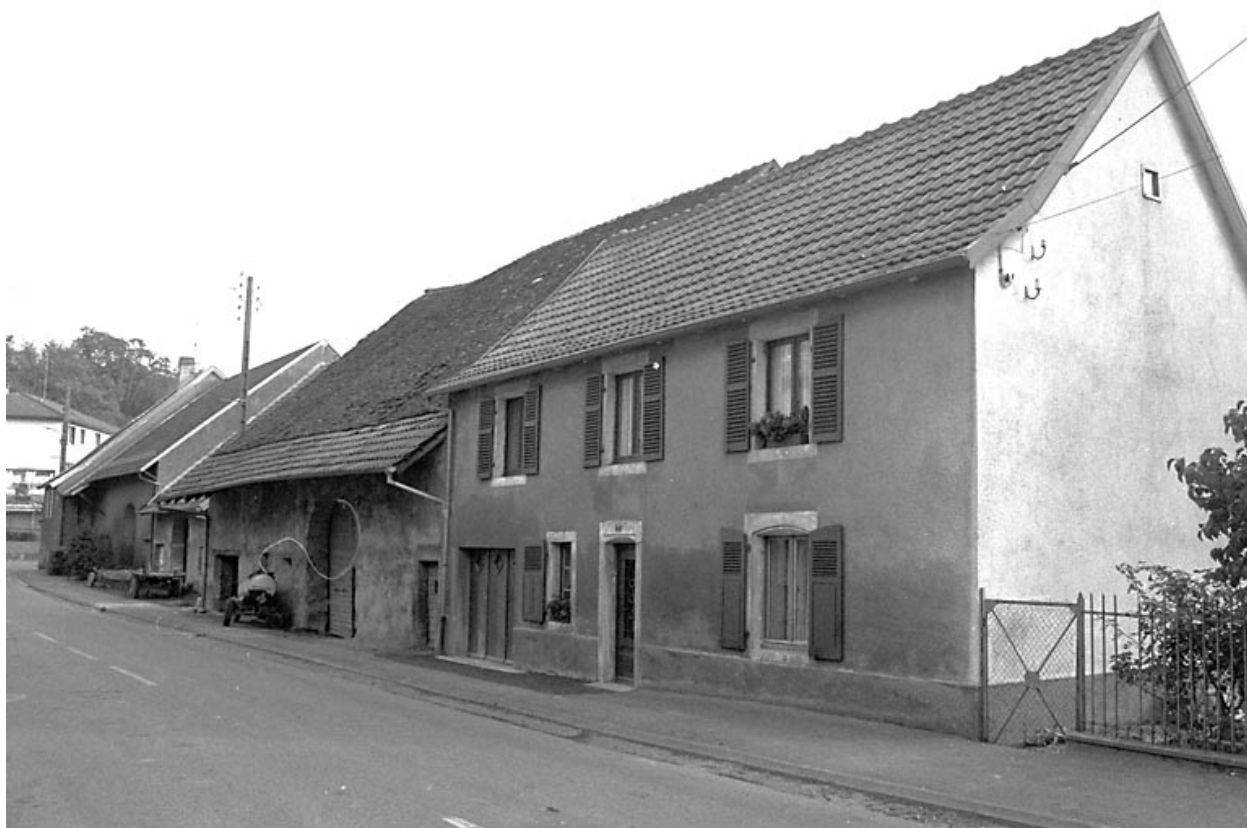
Ferme située rue de Courcelles.
