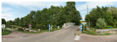
Vue du site. Phot. Pierre-Marie Barbe-Richaud IVR26_20175800378NUC2AQ
