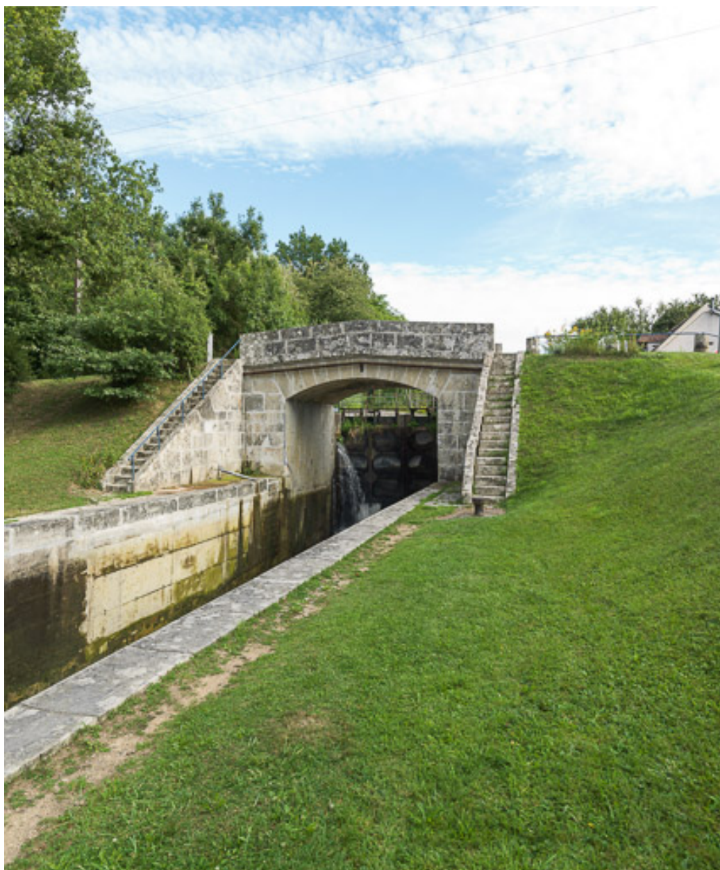
Vue d'ensemble du pont.
