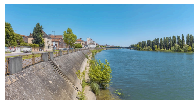
Le quai vu d'aval.
