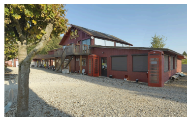
Remise transformée en capitainerie H2O. Phot. Thierry Kuntz IVR26_20112103393NUC4A
