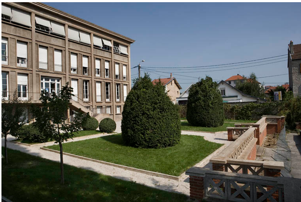
Jardin et face latérale gauche de l'usine.
