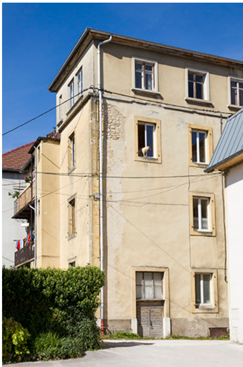
Façades latérale gauche et postérieure.
