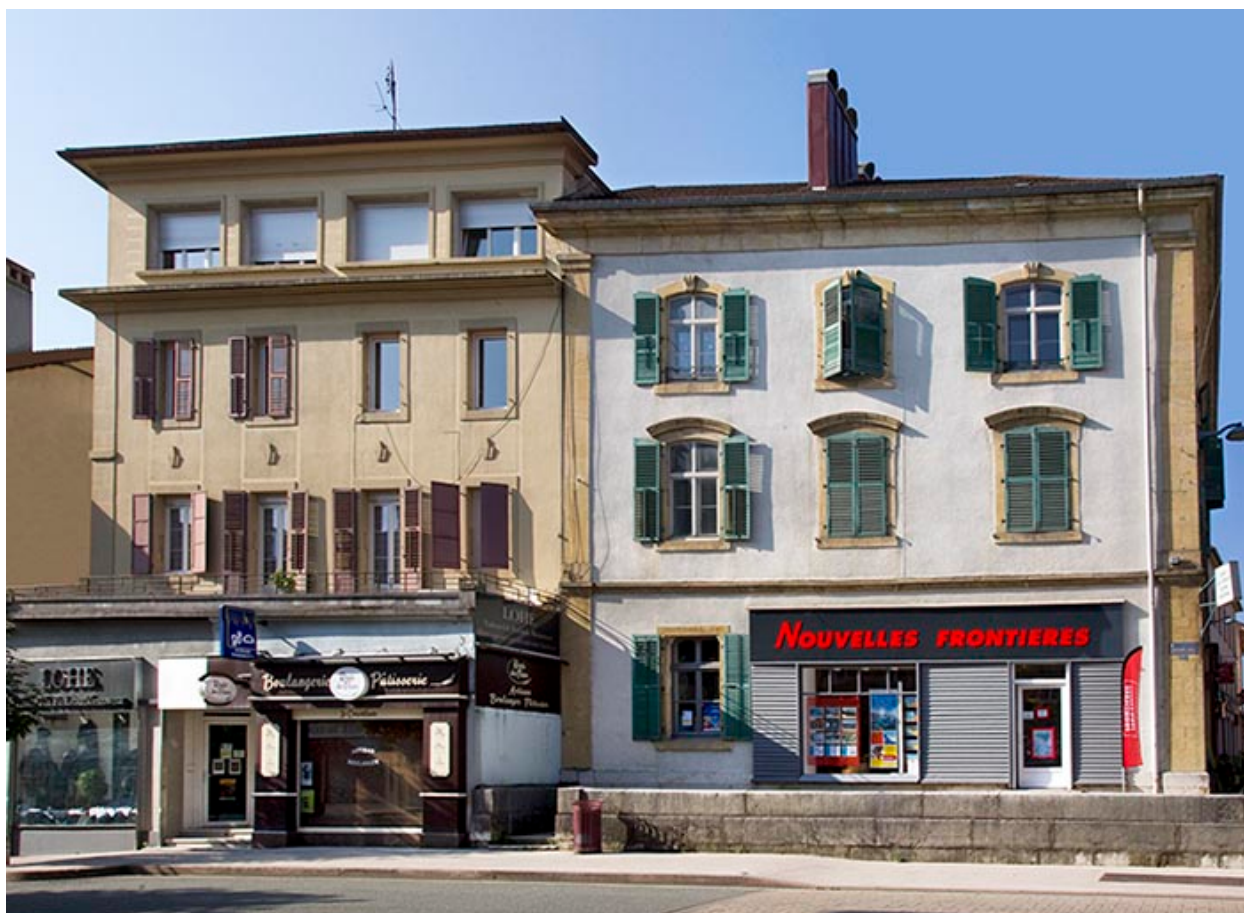
Façade des immeubles aux n° 19 et 21 Grande Rue.
