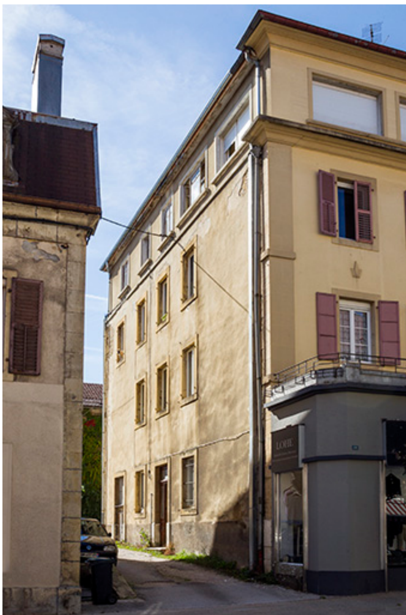
Façade latérale gauche, vue en enfilade.
