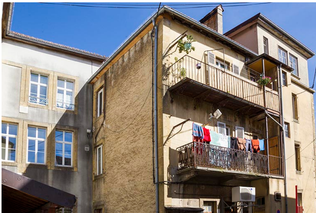
Façades postérieure et latérale droite.
