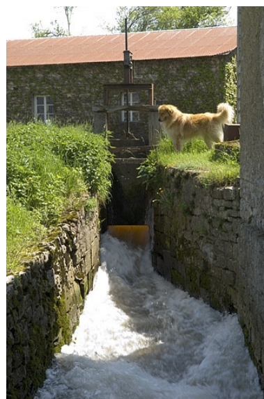
Bief d'amenée du moulin à huile. Phot. Jérôme Mongreville IVR43_20067000267NUCA
