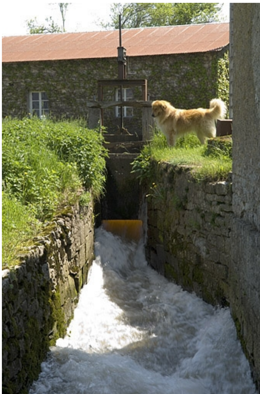
Bief d'amenée du moulin à huile.
