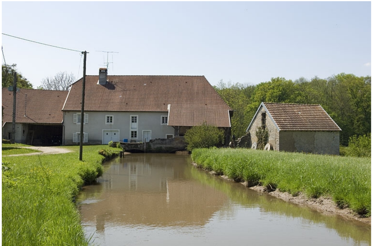
Vue d'ensemble depuis l'amont du bief.
