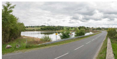
Vue générale du site et de la route-digue. Phot. Pierre-Marie Barbe-Richaud IVR26_20177100322NUC2AQ
