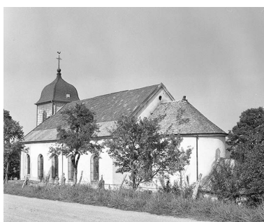
Face latérale droite depuis le chevet. Phot. Yves Sancey IVR43_19762501037X
