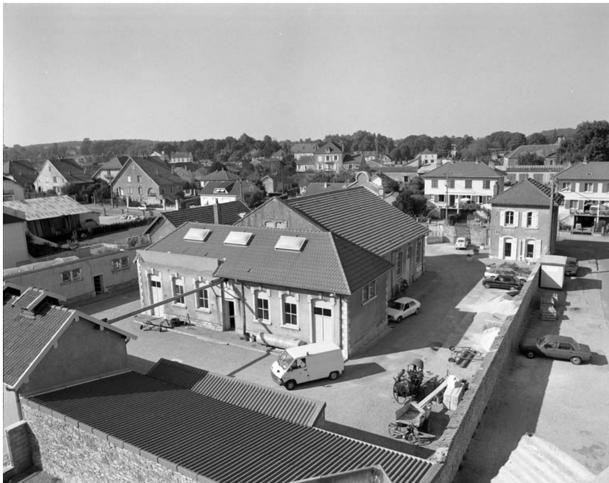
Vue d'ensemble depuis l'arrière de l'édifice.
