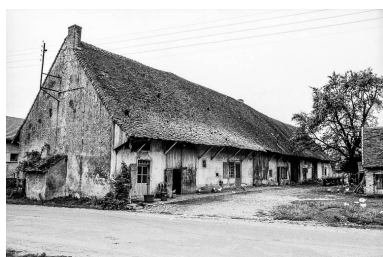
Ferme cadastrée 1949 B1 299 et 301 : façade postérieure. Phot. Bernard Pontefract IVR43_19753900466Z
