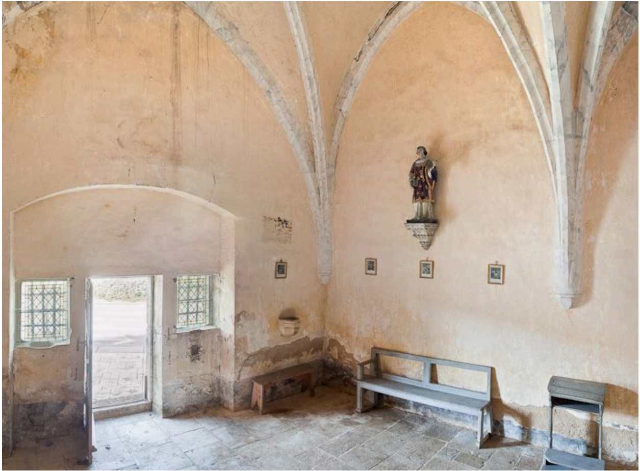
Vue d'ensemble depuis le lavabo.
