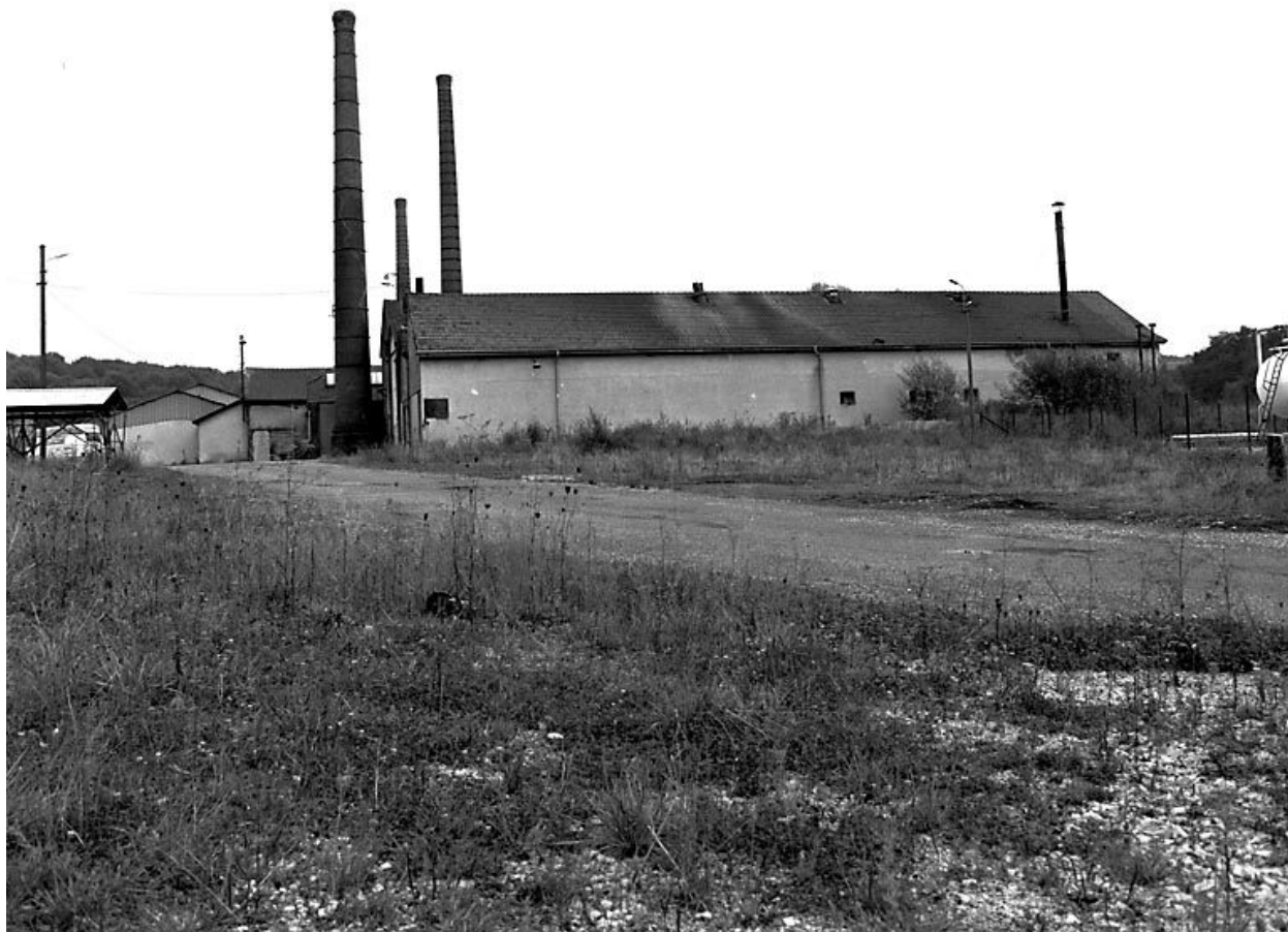
Vue de l'atelier d'émaillerie depuis l'ouest en 1981.
