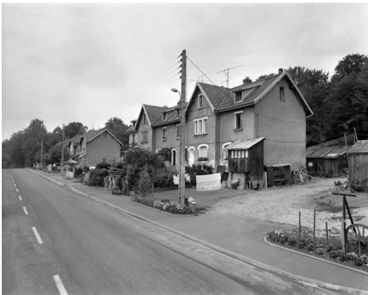
Les logements ouvriers au nord de l'usine, en 1986.
