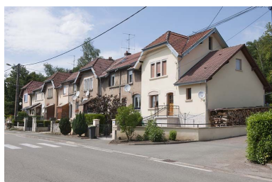
Logement ouvrier P. Phot. Jérôme Mongreville IVR43_20112501213NUC4A
