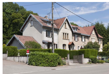
Logement ouvrier Q. Phot. Jérôme Mongreville IVR43_20112501212NUC4A
