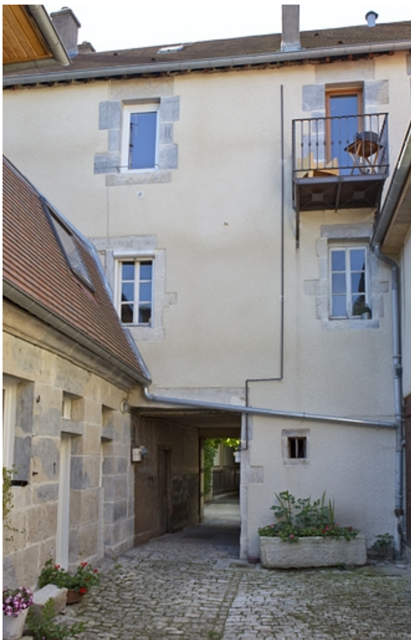
Vue d'ensemble de la façade postérieure du logis secondaire.
