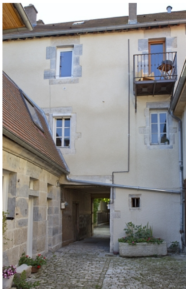
Vue d'ensemble de la façade postérieure du logis secondaire. Phot. Yves Sancey IVR43_20102500810NUC2A
