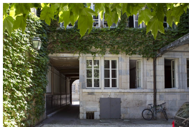
Façade postérieure du logis principal : détail du rez-de-chaussée. Phot. Yves Sancey IVR43_20102500815NUC2A
