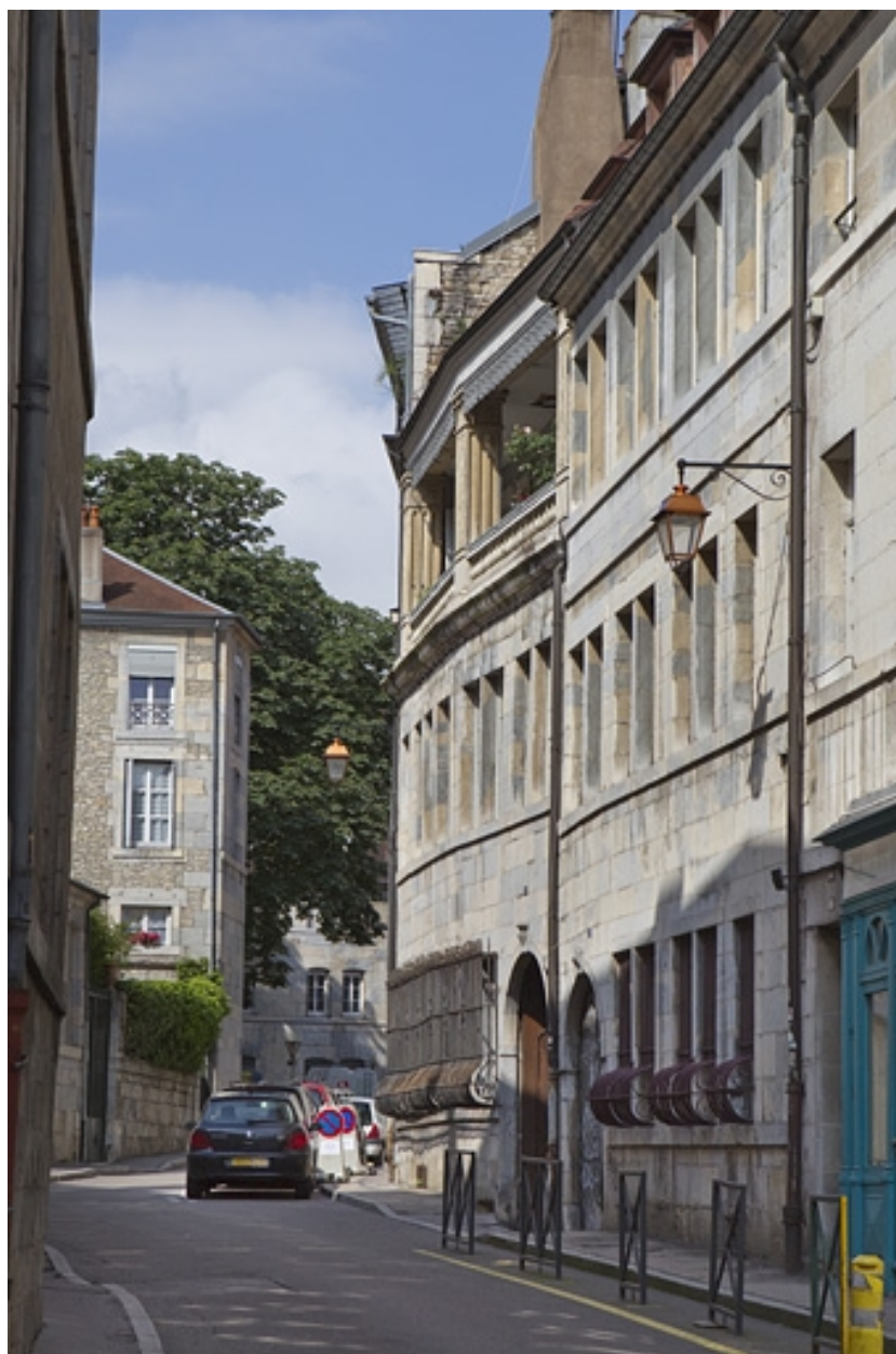
Vue d'ensemble du logis principal depuis la rue de trois quarts droit.
