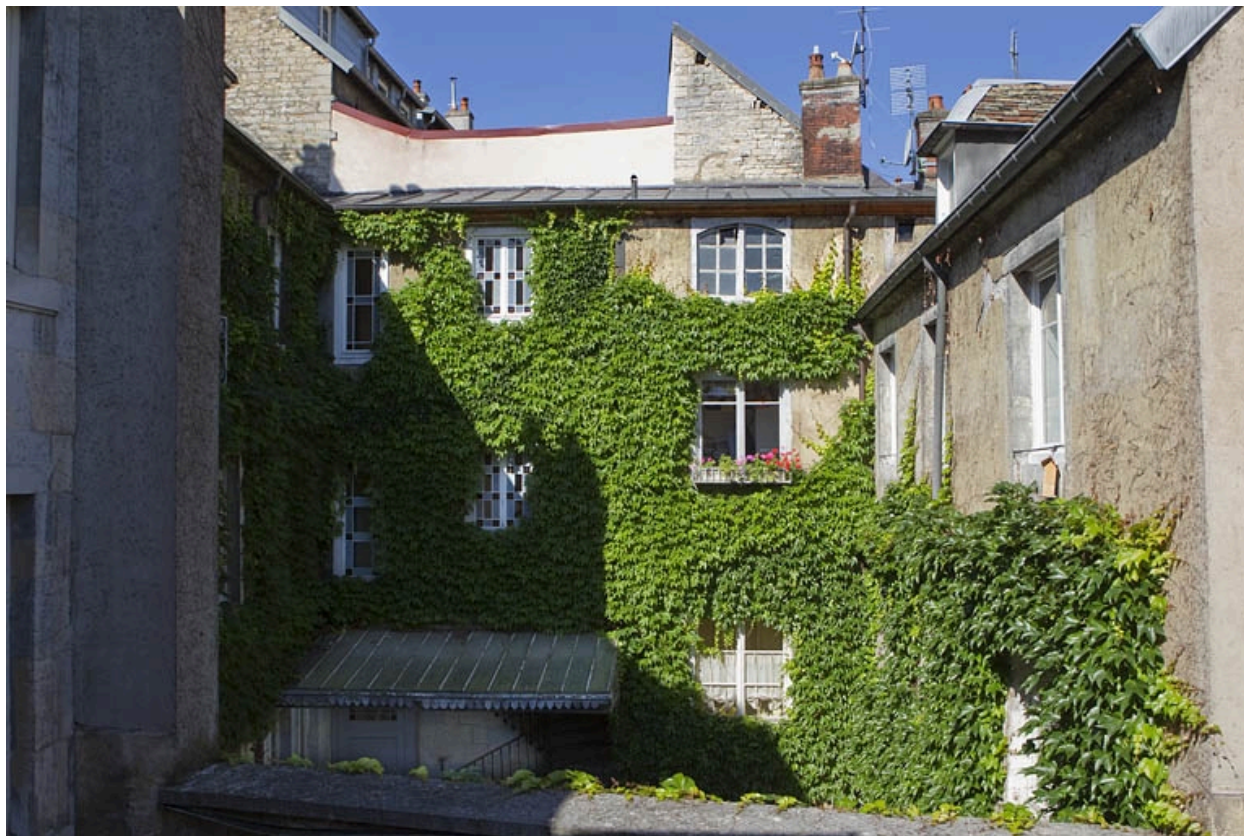
Vue d'ensemble de l'aile contenant l'escalier principal.
