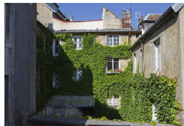
Vue d'ensemble de l'aile contenant l'escalier principal. Phot. Yves Sancey IVR43_20102500808NUC2A
