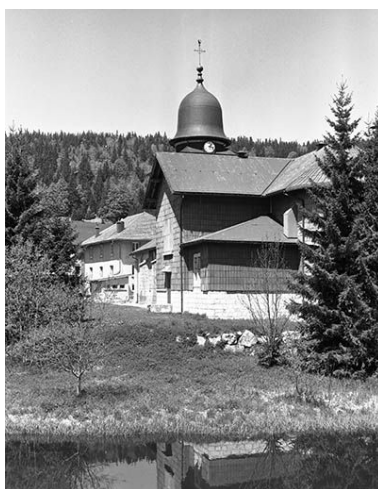
Vue de l'église depuis le sud. Phot. Jérôme Mongreville IVR43_20003900687X
