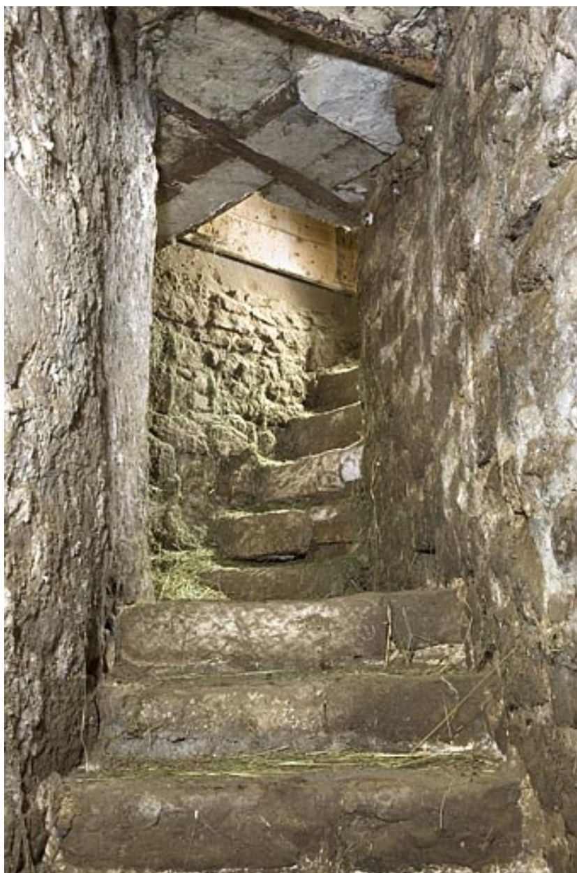
Escalier en pierre (cadrage vertical).
