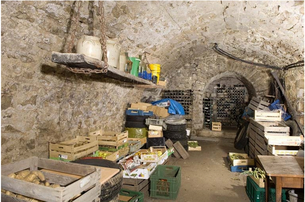
Sous-sol ("cave") voûté en berceau.
