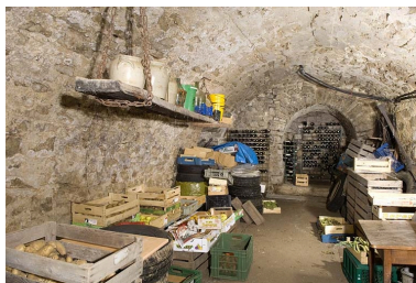
Sous-sol ("cave") voûté en berceau. Phot. Jérôme Mongreville IVR43_20092500024NUC2A
