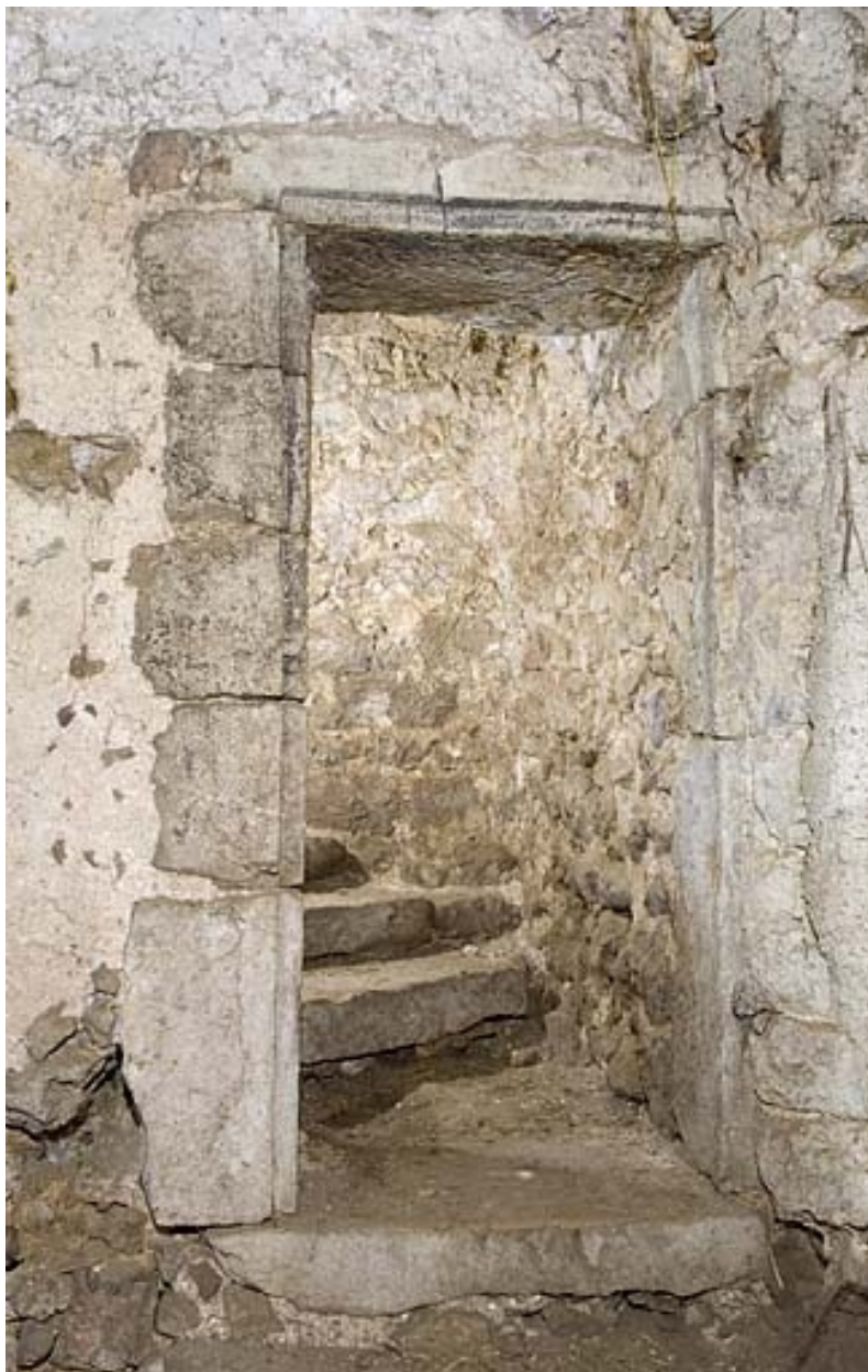
Porte donnant accès à l'escalier en pierre.
