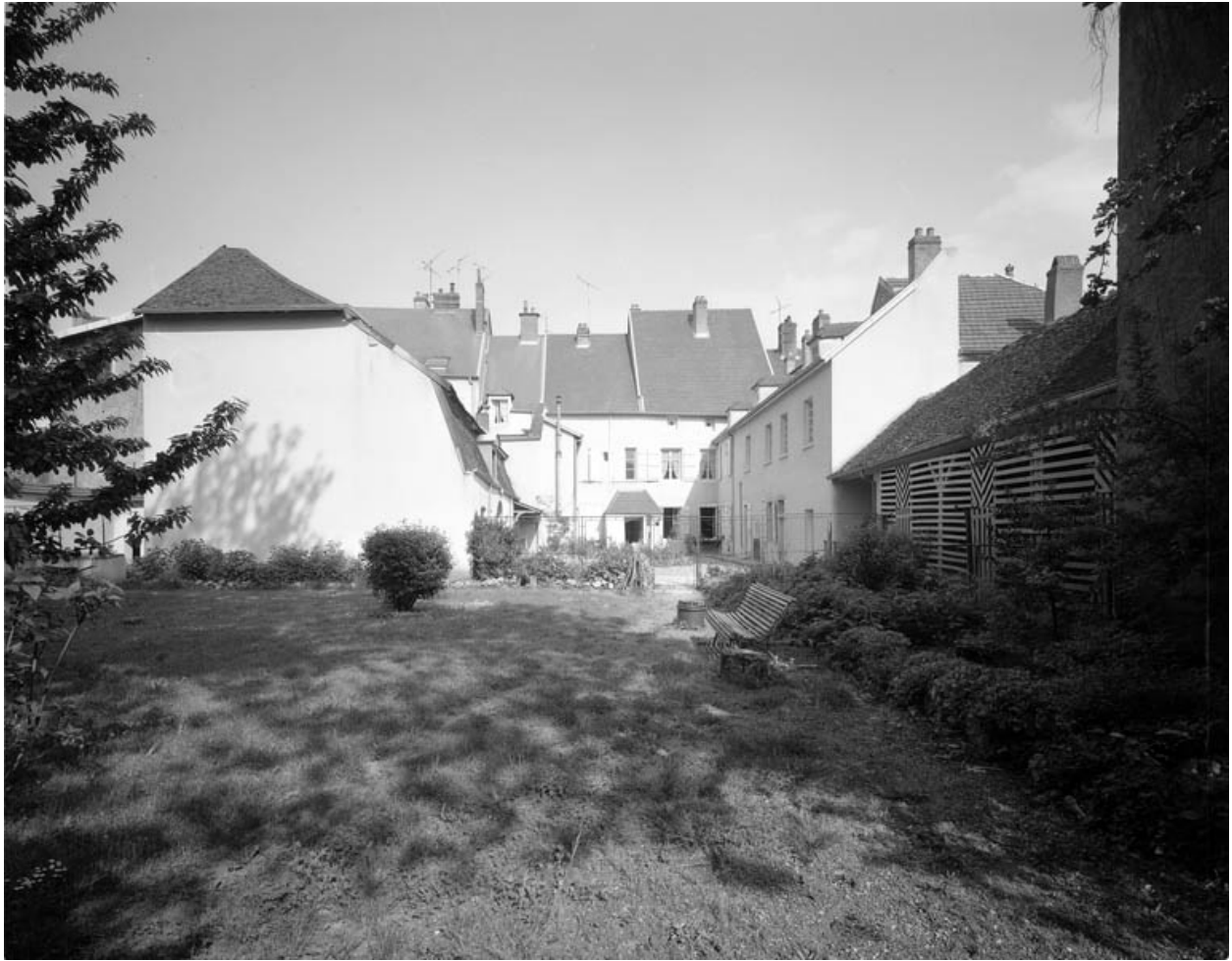
Façade postérieure : vue éloignée.
