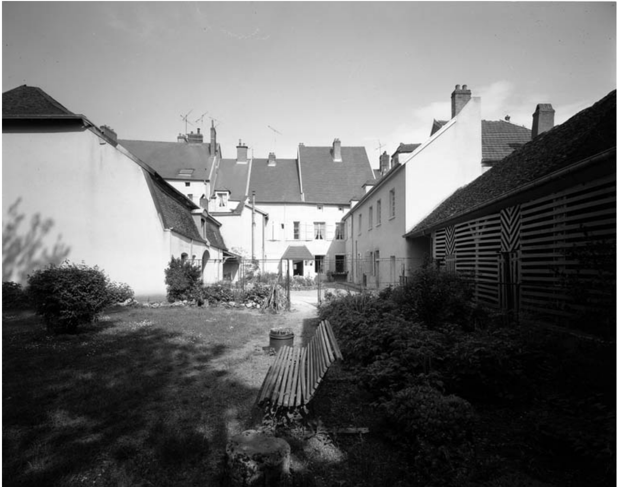
Façades sur cour.
