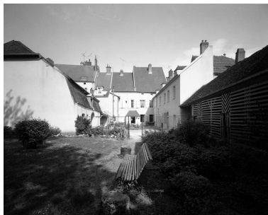
Façades sur cour. Phot. Yves Sancey IVR43_19897000255V
