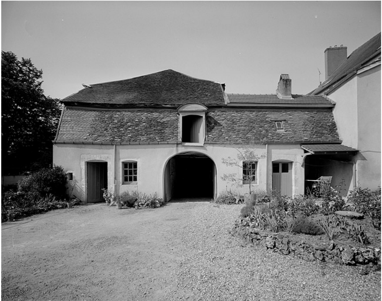
Logement de face, à droite de la cour.
