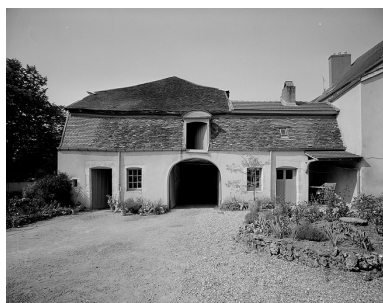
Logement de face, à droite de la cour. Phot. Yves Sancey IVR43_19897000257V
