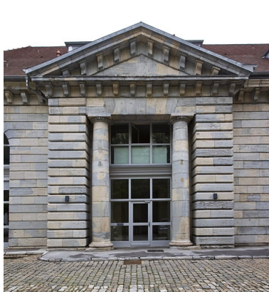
Orangerie : détail de l'avant-corps central. Phot. Yves Sancey IVR43_20112501895NUC2A
