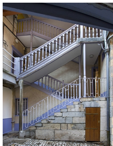
Vue d'ensemble de l'escalier à cage ouverte dans la première cour. Phot. Yves Sancey IVR43_20122500381NUC2A
