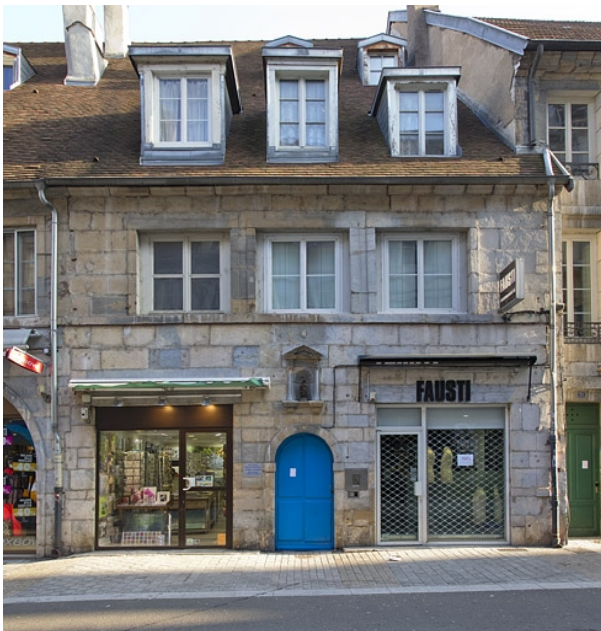
Logis principal, façade antérieure : de face.
