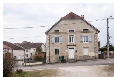
Vue sur la façade principale. Phot. Jérôme Mongreville IVR43_20167000219NUC4A
