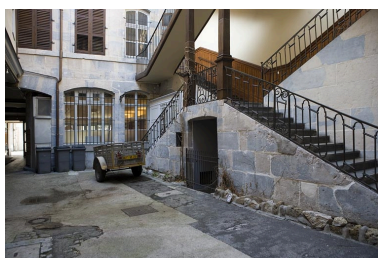
Détail de la première volée de l'escalier à cage ouverte depuis le fond de la première cour. Phot. Yves Sancey IVR43_20082500217NUC2A
