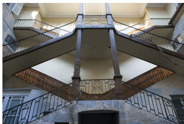
Détail de l'escalier à cage ouverte, de face. Phot. Yves Sancey IVR43_20082500222NUC2A
