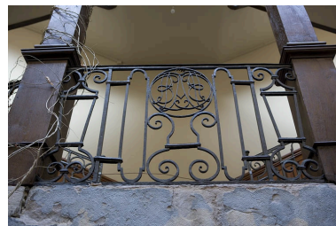
Détail de la ferronnerie de l'escalier à cage ouverte. Phot. Yves Sancey IVR43_20082500214NUC2A
