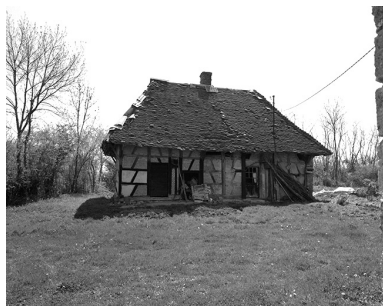
Ferme cadastrée 1969 AL 137 : vue d'ensemble. Phot. Bernard Lardière IVR43_19793900314X
