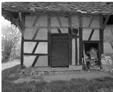
Ferme cadastrée 1969 AL 137 : vue du colombage. Phot. Bernard Lardière IVR43_19793900315X
