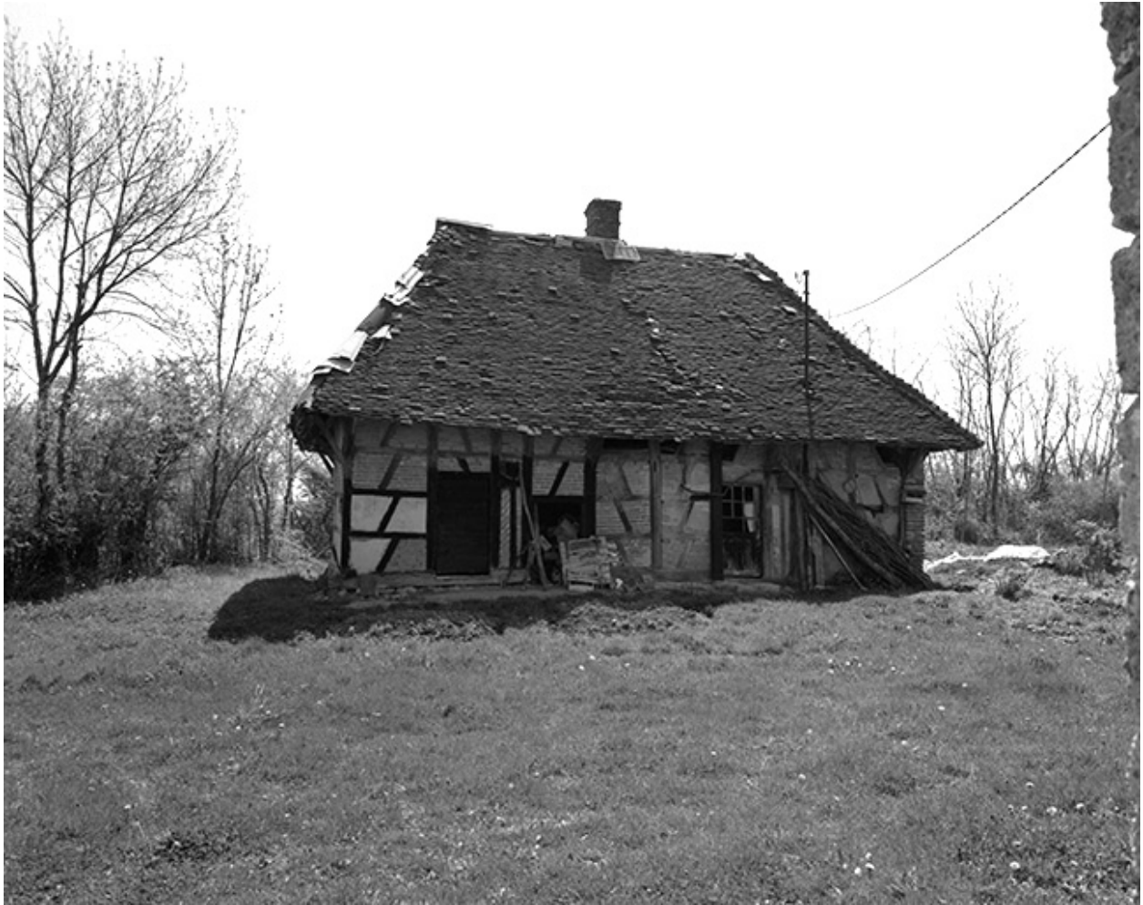
Ferme cadastrée 1969 AL 137 : vue d'ensemble.
