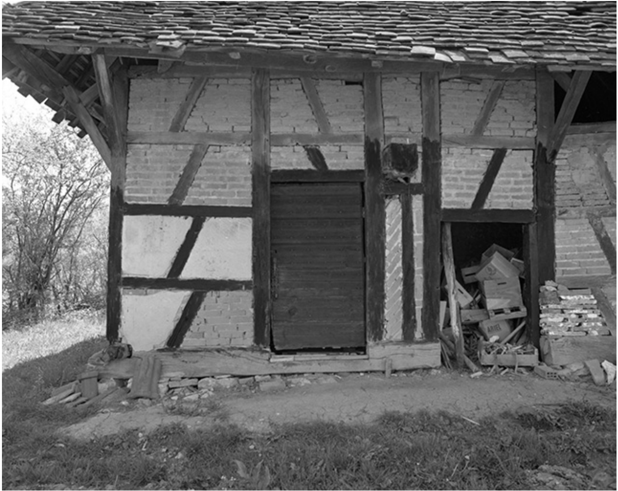
Ferme cadastrée 1969 AL 137 : vue du colombage.
