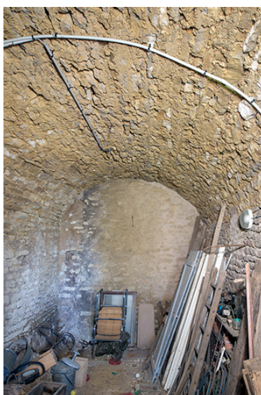
Le cellier servant de cuverie, depuis l'entrée. Phot. Nicolas Waltefaugle IVR26_20258900240NUC4A
