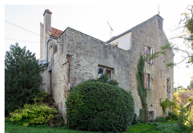
L'angle ouest. Phot. Nicolas Waltefaugle IVR26_20258900235NUC4A
