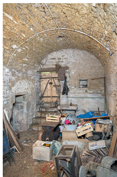
Le cellier servant de cuverie, depuis le fond. Phot. Nicolas Waltefaugle IVR26_20258900241NUC4A
