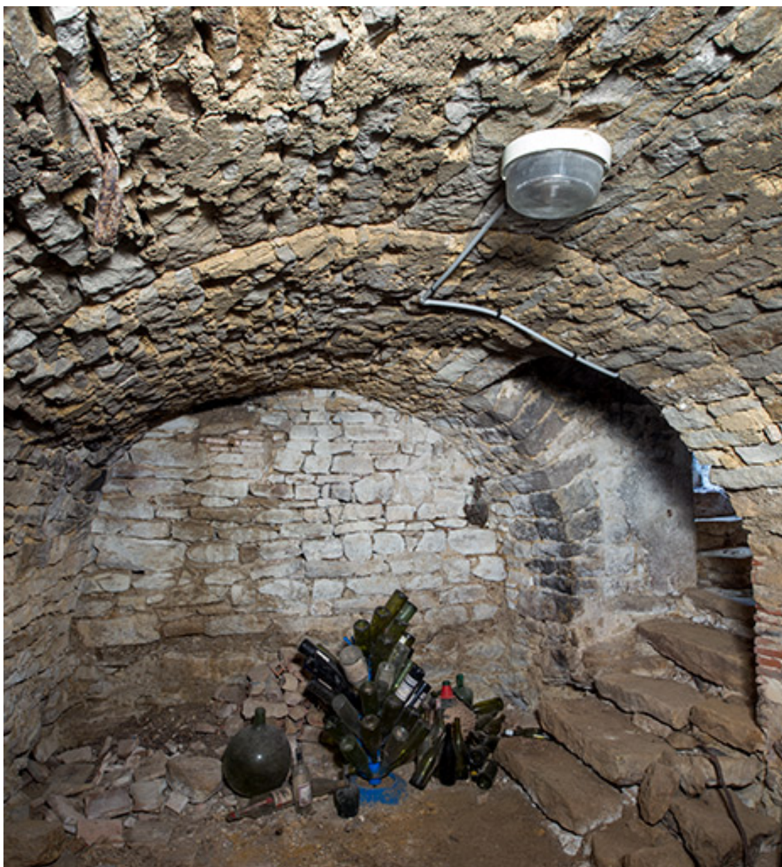
Le cellier placé sous le fruitier, depuis le fond.
