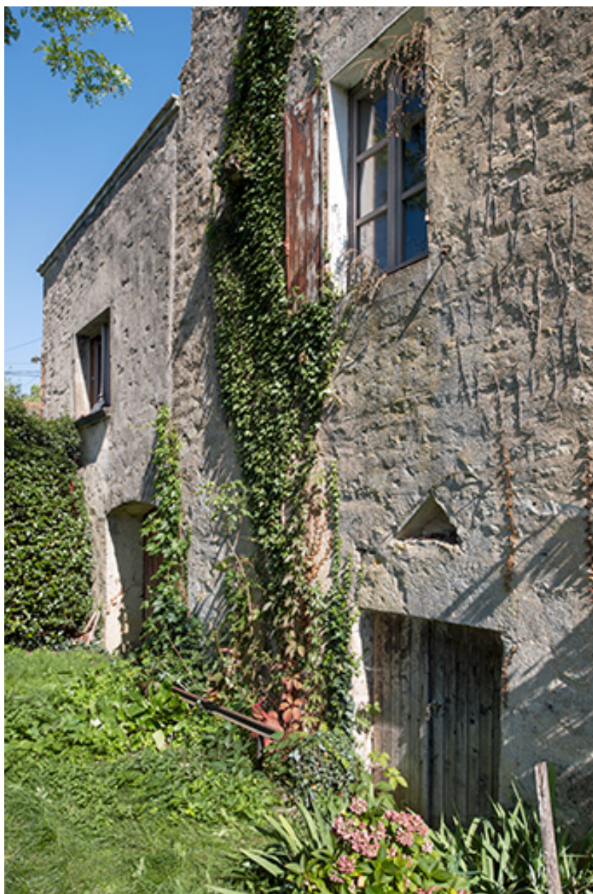
Face ouest avec entrée des celliers (premier plan) et du réduit sous l'ancienne cuisine (au fond).
