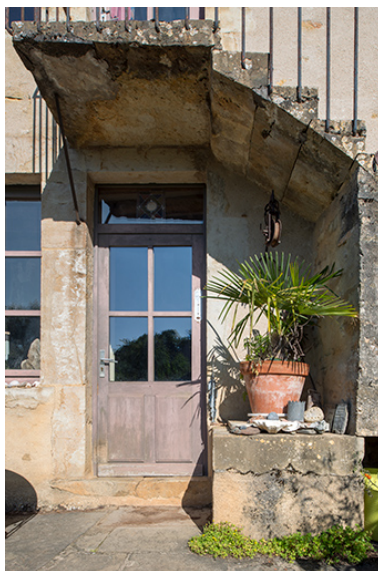
L'entrée du rez-de-chaussée depuis le jardin, la citerne (à droite).
