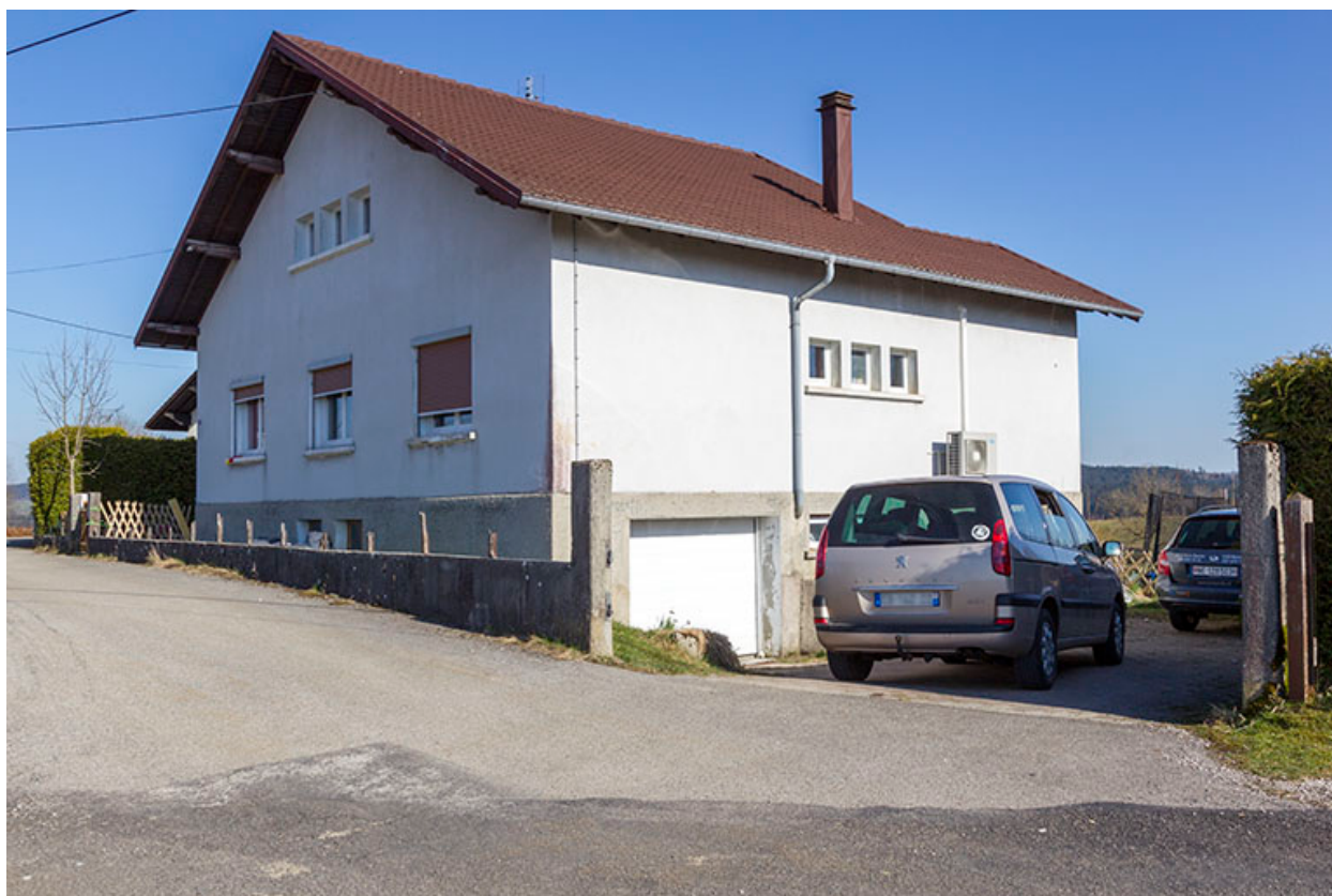
Façades antérieures et latérale droite.
