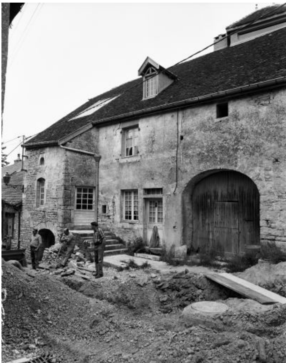
Façade antérieure, partie gauche.
