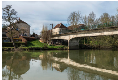
Le pont et le hameau en arrière-plan. Phot. Jérôme Mongreville IVR43_20187000165NUC4A
