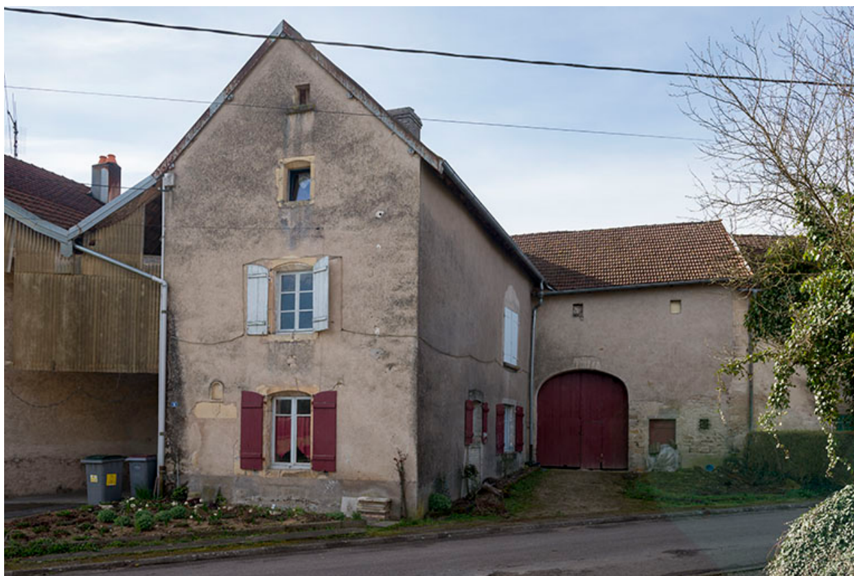
Ferme en équerre, rue du Bac.
