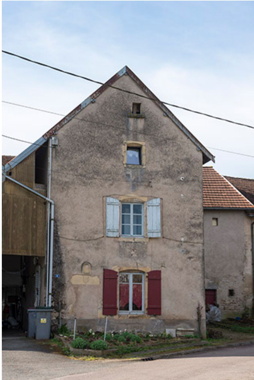
Détail sur les baies du mur pignon.
