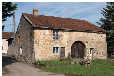
Ferme, rue du Bac. Phot. Jérôme Mongreville IVR43_20187000162NUC4A
