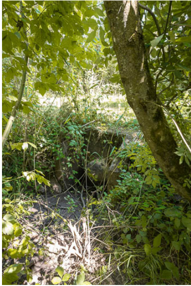
Vue de l'aqueduc.
