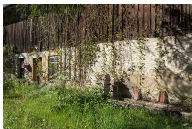
Façade latérale gauche, avec fontaine. Phot. Sonia Dourlot IVR43_20172500730NUC4A
