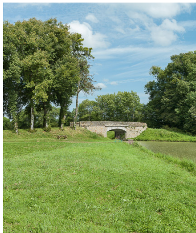
Vue d'ensemble du pont et du site. Phot. Pierre-Marie Barbe-Richaud IVR26_20175800165NUC2A
