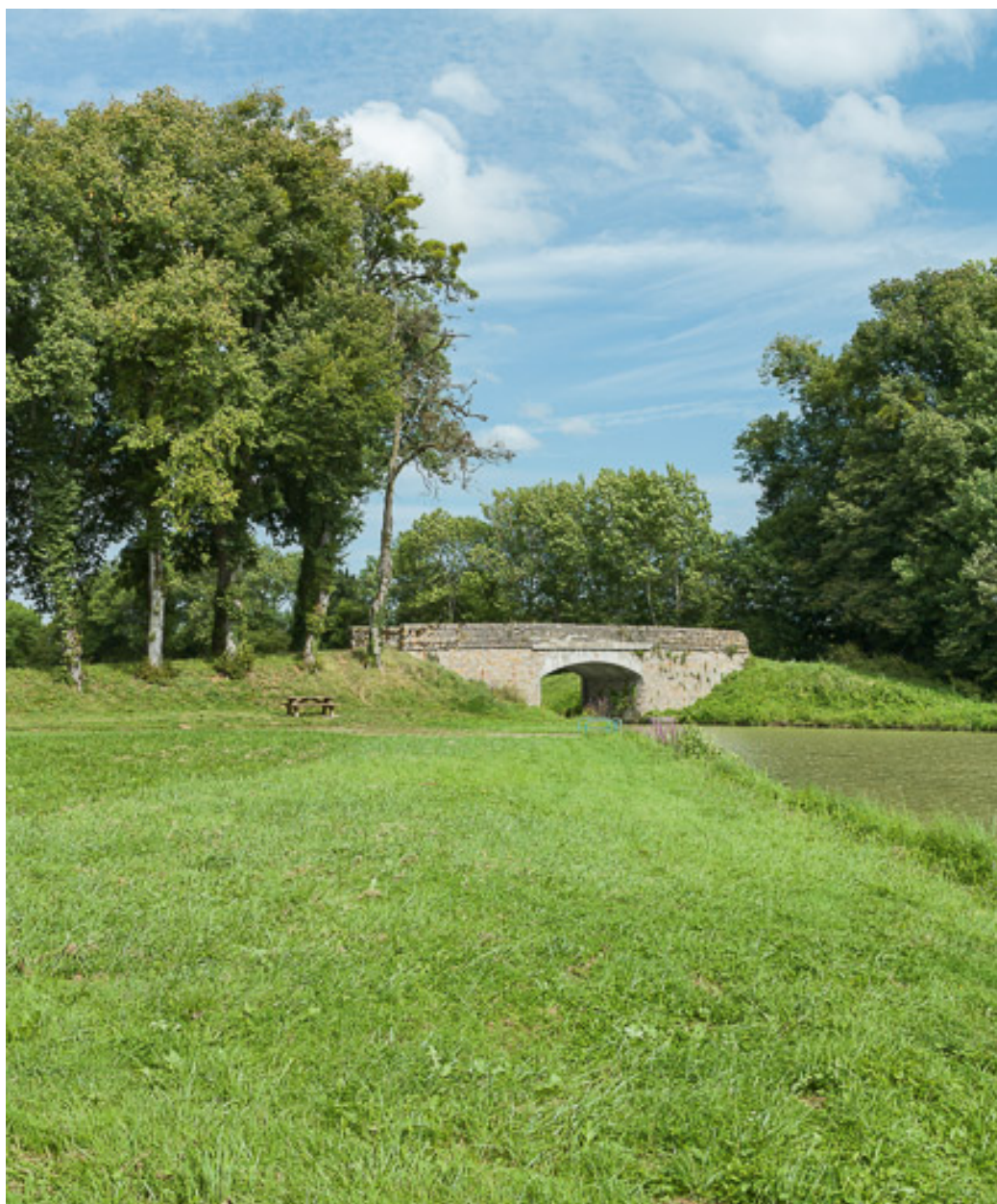
Vue d'ensemble du pont et du site.
