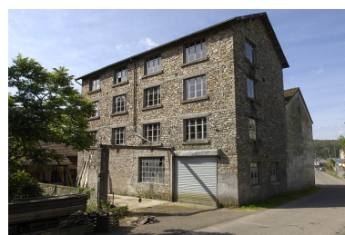
Extension orientale de l'atelier de fabrication. Phot. Jérôme Mongreville IVR43_20057000369NUCA
