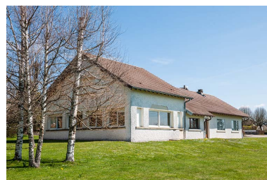
Vue d'ensemble, depuis l'ouest (façades postérieure et latérale gauche). Phot. Jérôme Mongreville IVR43_20142500237NUC4A
