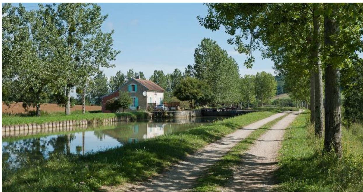
Vue du site d'écluse depuis l'amont.
