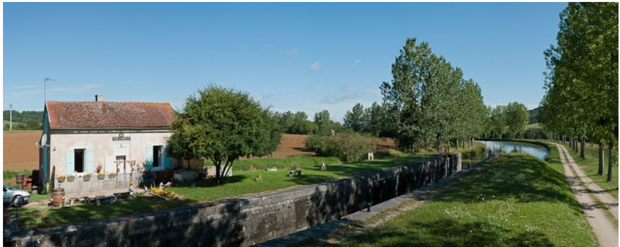
Vue d'ensemble du site d'écluse.
