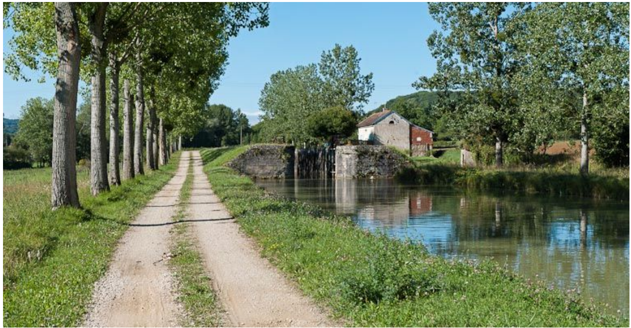
Vue du site d'écluse depuis l'aval.
