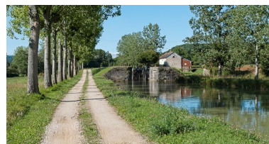
Vue du site d'écluse depuis l'aval. Phot. Pierre-Marie Barbe-Richaud IVR26_20112103836NUC4AQ
