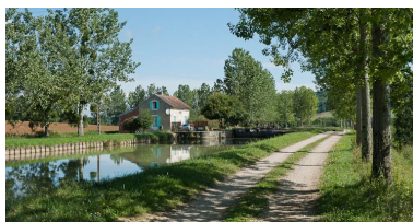
Vue du site d'écluse depuis l'amont. Phot. Pierre-Marie Barbe-Richaud IVR26_20112103840NUC4AQ
