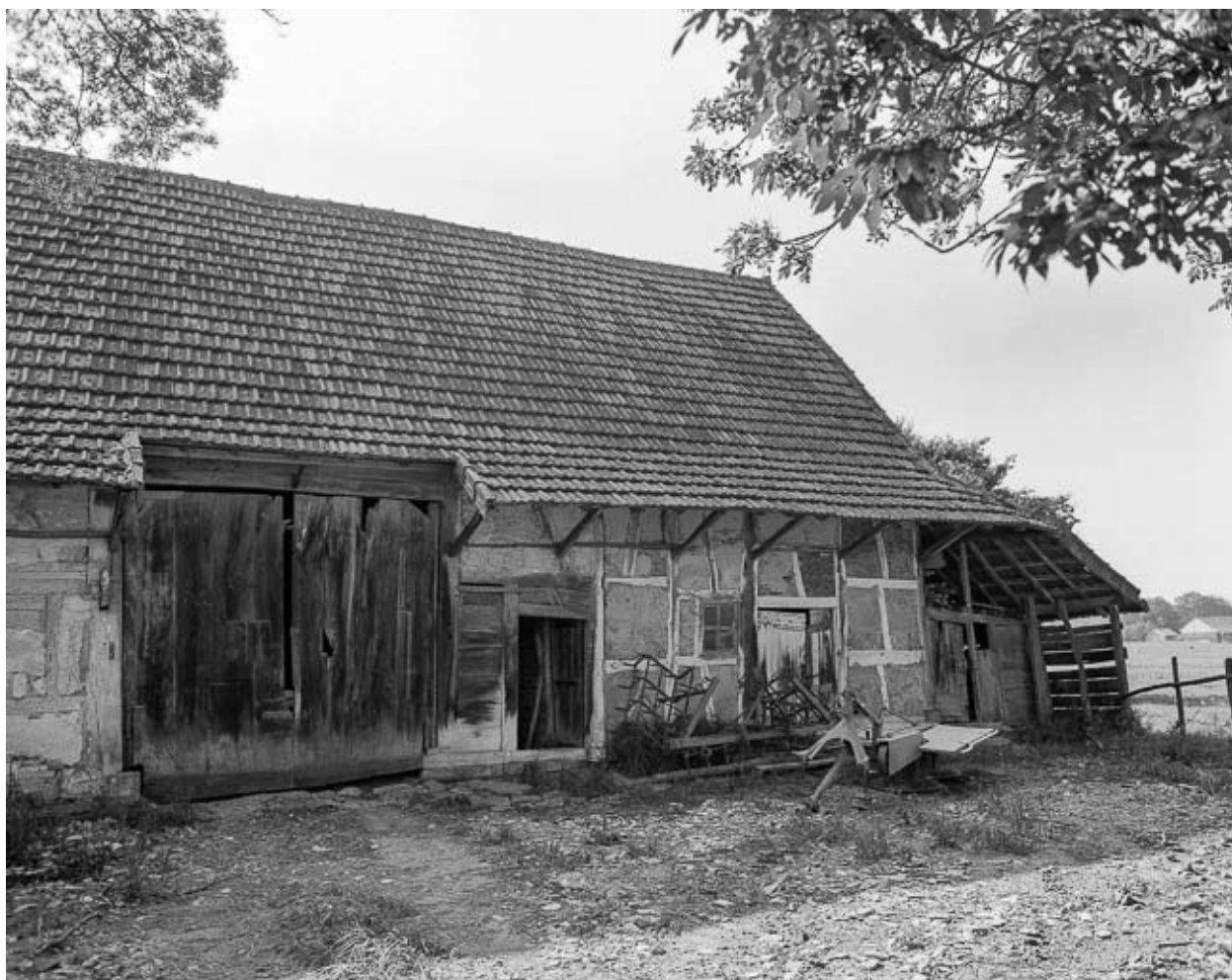
Façade antérieure : partie droite.
