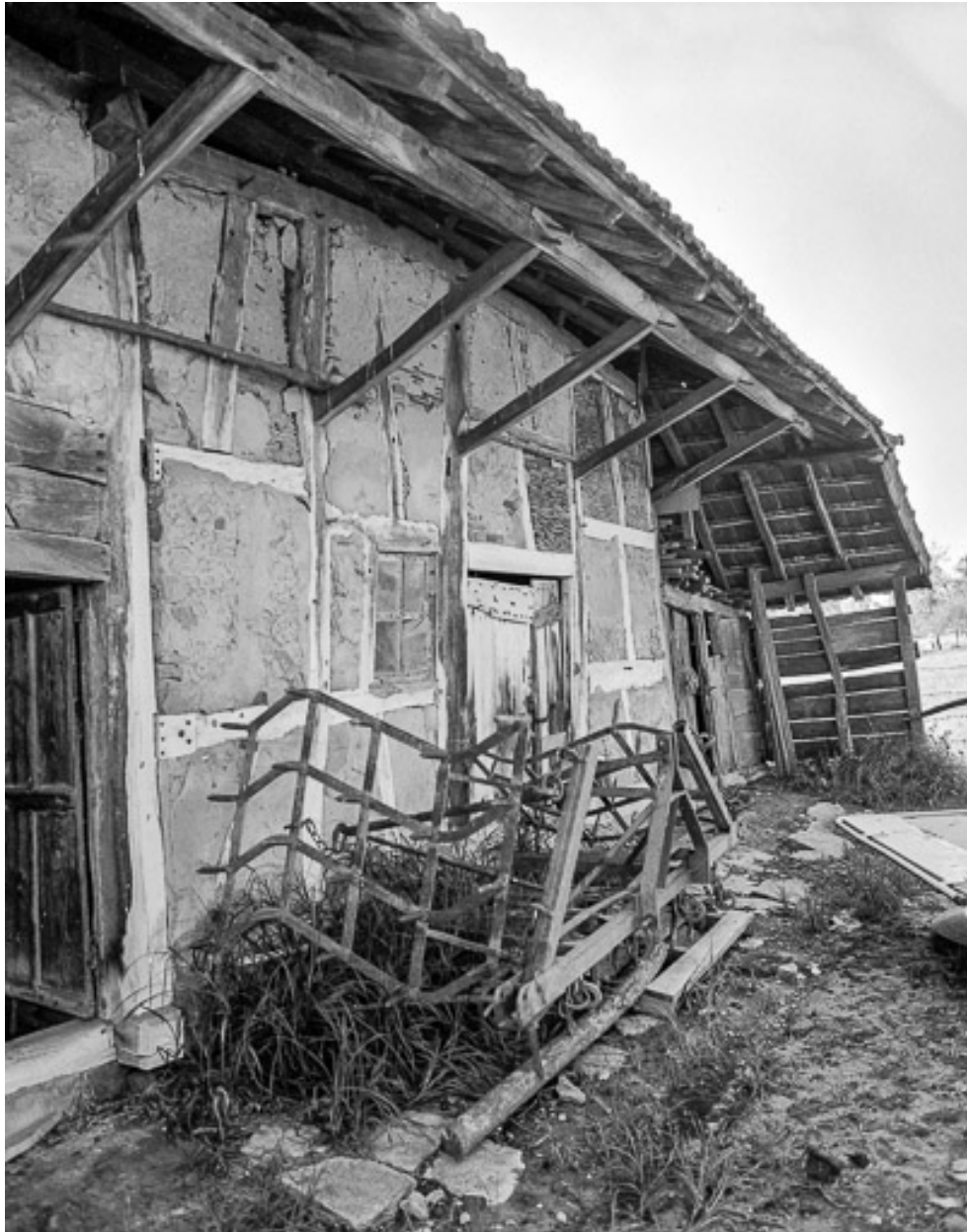
Façade antérieure : partie droite.
