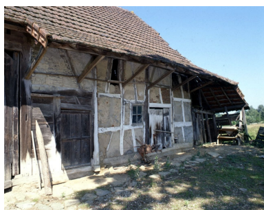
Façade antérieure : partie droite en pan de bois et en brique. Phot. Yves Sancey IVR43_19903901149XA
