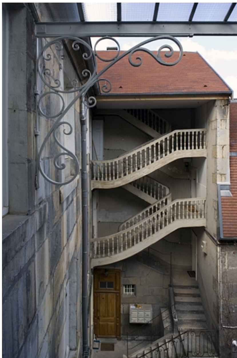
Vue d'ensemble de l'escalier droit depuis l'escalier gauche.
