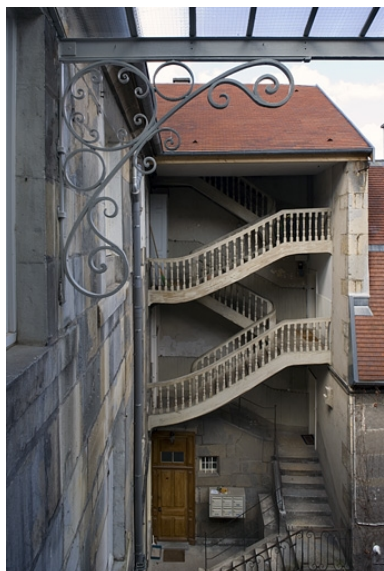
Vue d'ensemble de l'escalier droit depuis l'escalier gauche. Phot. Yves Sancey IVR43_20072500327NUCA
