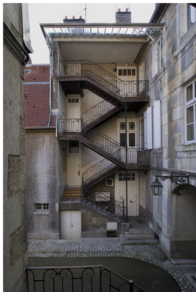
Vue d'ensemble de l'escalier à cage ouverte à gauche de la cour. Phot. Yves Sancey IVR43_20072500323NUCA
