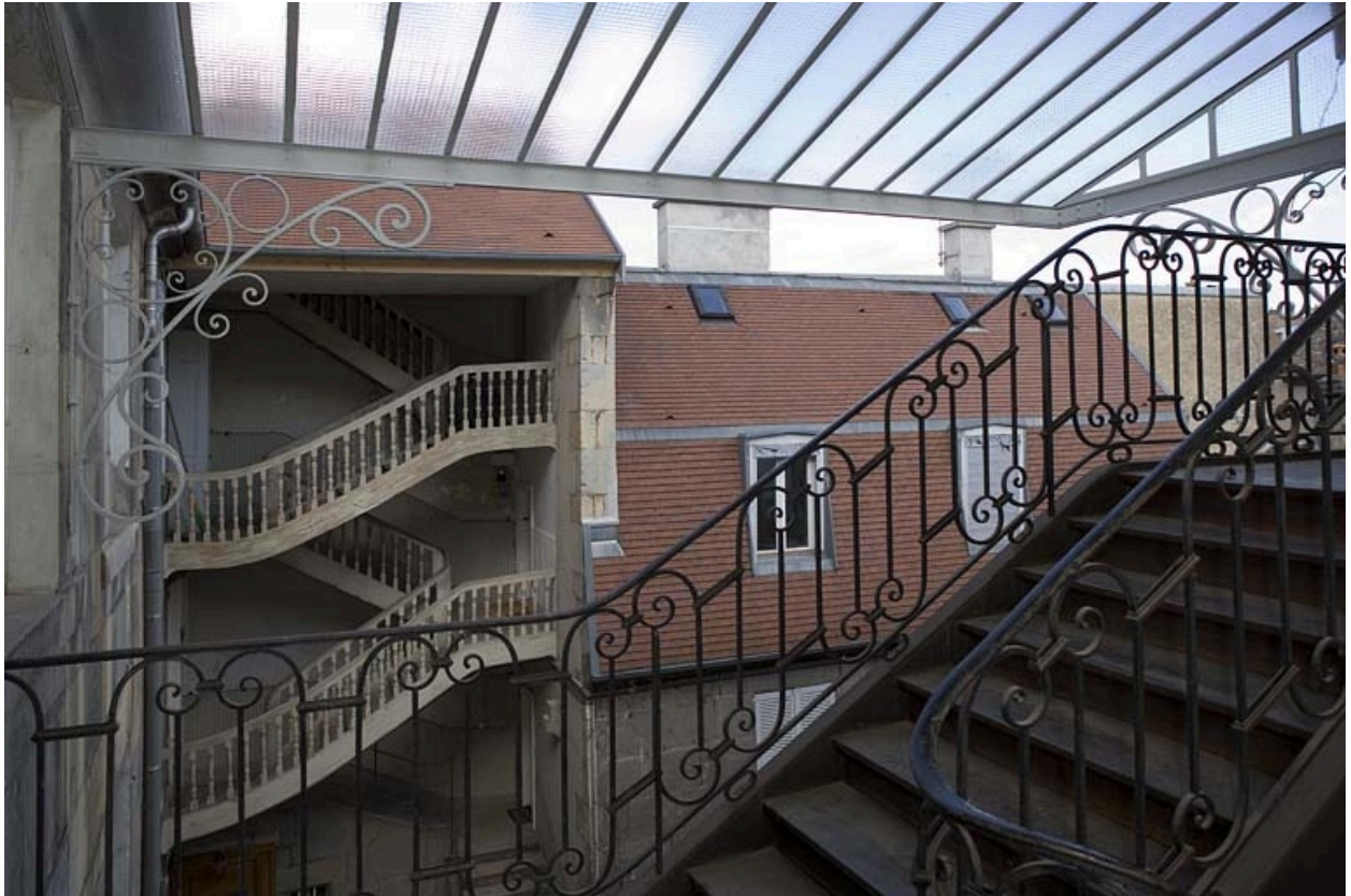
Détail de l'escalier droit depuis l'escalier gauche.
