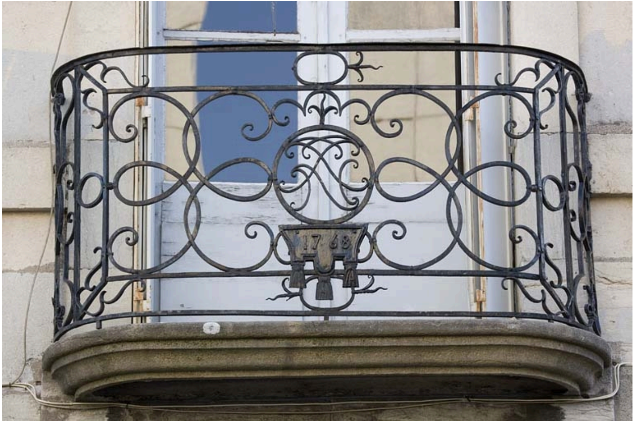
Détail du balcon : vue rapprochée.
