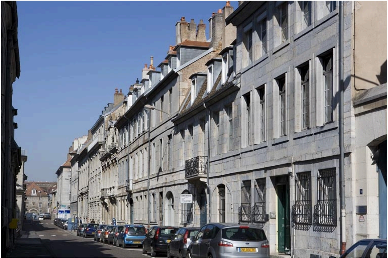
Vue d'ensemble de la maison dans l'alignement de la rue.
