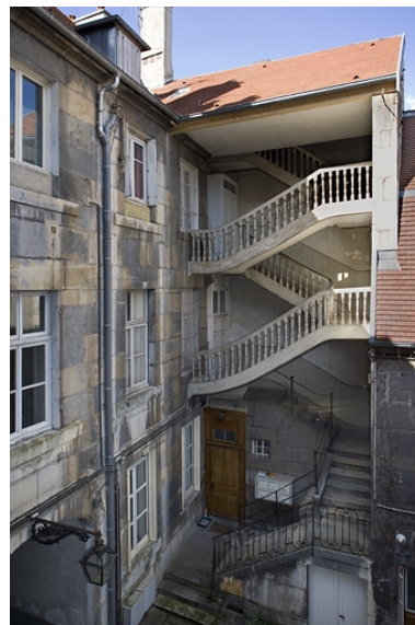
Vue d'ensemble de l'escalier à droite de la cour. Phot. Yves Sancey IVR43_20072500325NUCA
