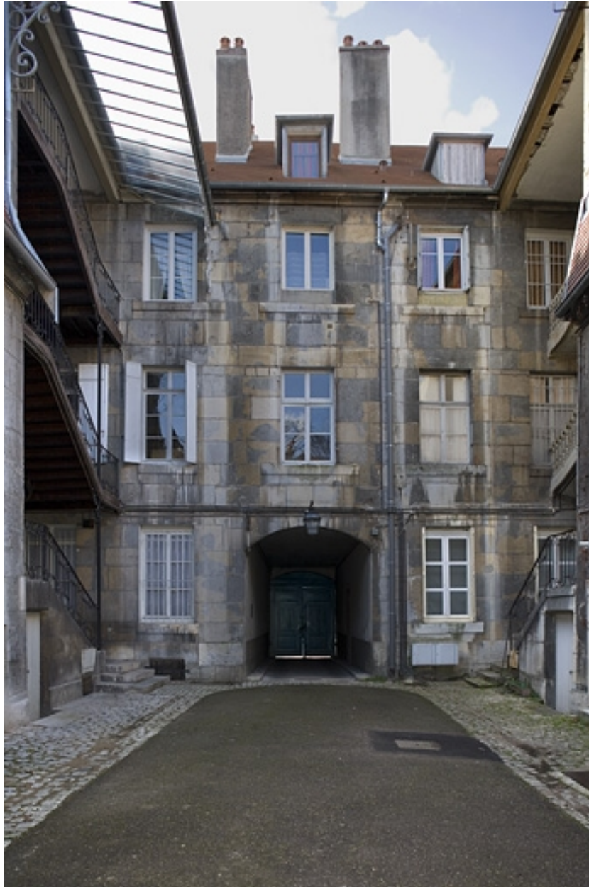
Vue d'ensemble de façade sur cour du logis principal.
