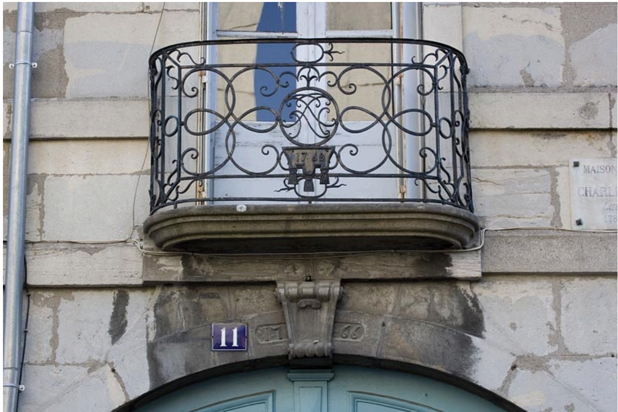
Détail du balcon en fer forgé sur rue, de face.
