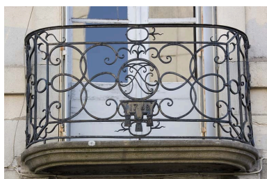
Détail du balcon : vue rapprochée. Phot. Yves Sancey IVR43_20072500336NUCA
