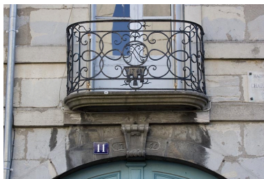
Détail du balcon en fer forgé sur rue, de face. Phot. Yves Sancey IVR43_20072500333NUCA
