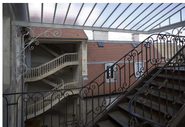
Détail de l'escalier droit depuis l'escalier gauche. Phot. Yves Sancey IVR43_20072500326NUCA
