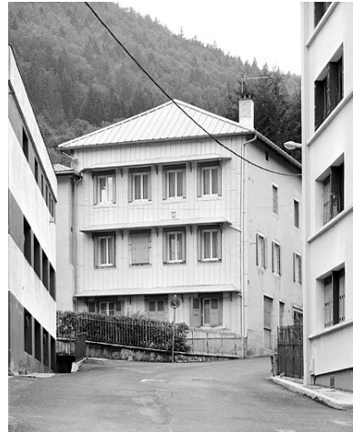
Immeuble : élévation orientale.
