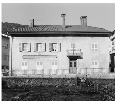
Maison : élévation latérale droite. Phot. Yves Sancey IVR43_20033900419X
