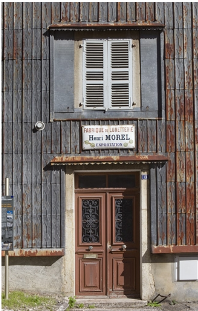
Maison : travée centrale de l'élévation antérieure.
