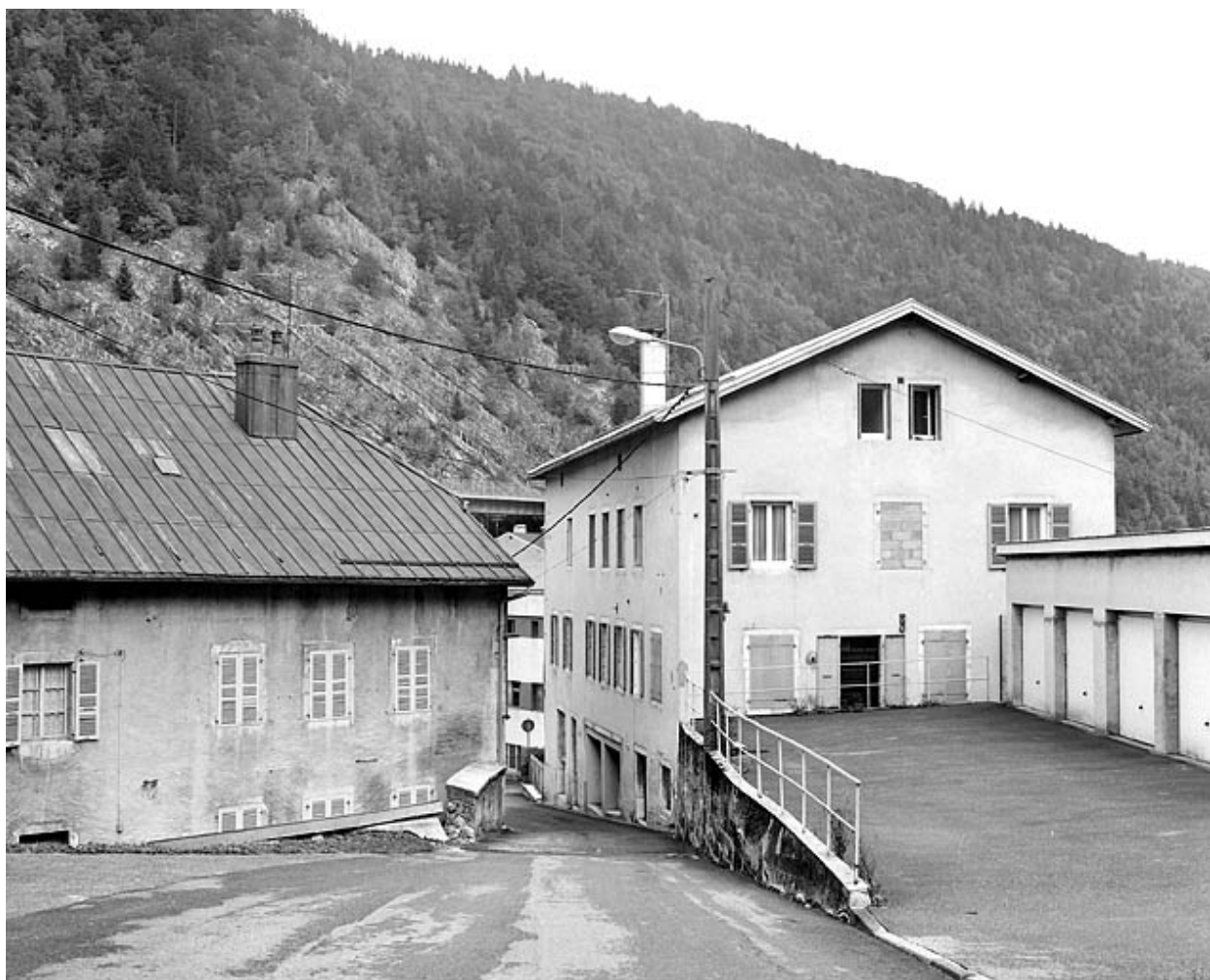
Immeuble : élévation occidentale.
