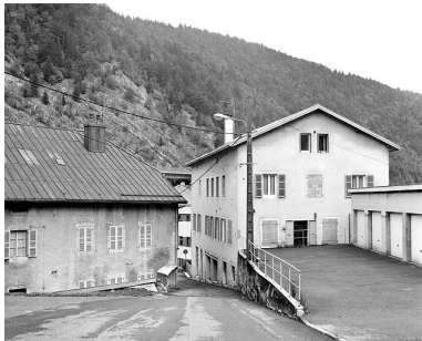
Immeuble : élévation occidentale.
