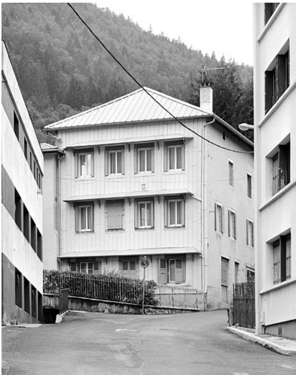
Immeuble : élévation orientale.
