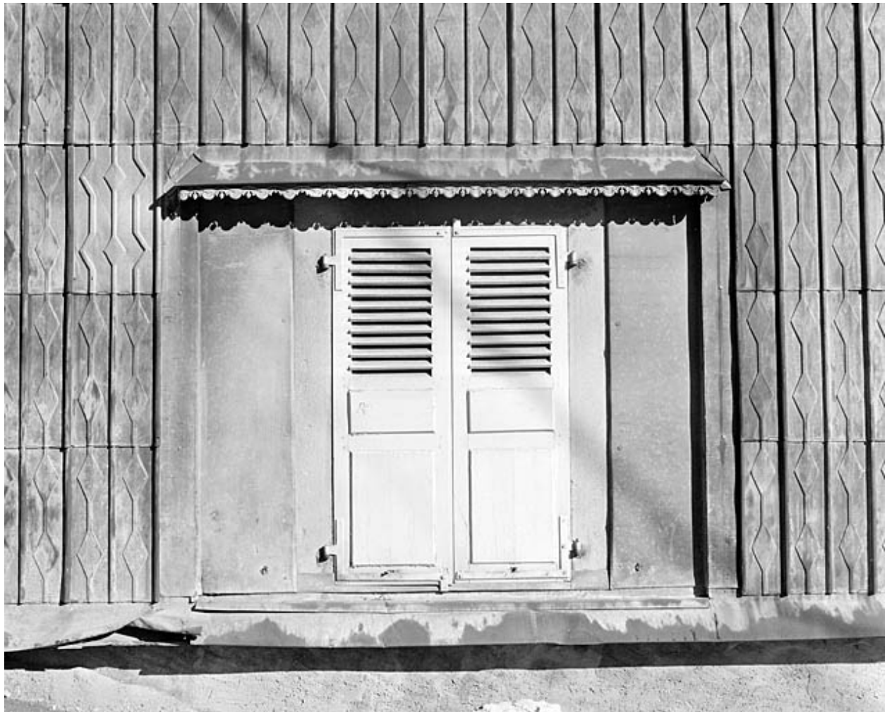
Maison : essentage de tôle et fenêtre du rez-de-chaussée.
