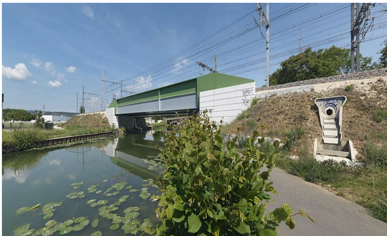
Vue d'ensemble d'aval.
