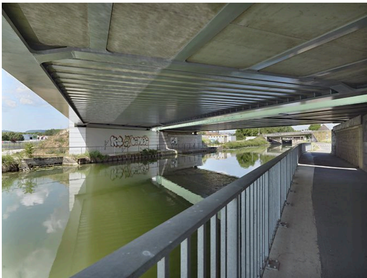
Vue du dessous du tablier.
