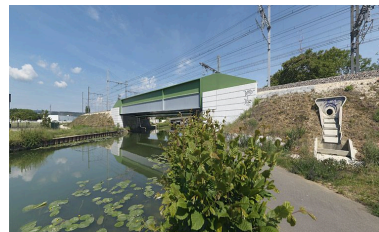
Vue d'ensemble d'aval. Phot. Thierry Kuntz IVR26_20112102981NUC4A
