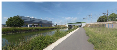
Vue d'ensemble du pont et de son environnement. Phot. Thierry Kuntz IVR26_20112102982NUC4A
