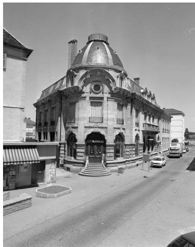
Vue d'ensemble éloignée. Phot. Yves Sancey IVR43_19917000402X
