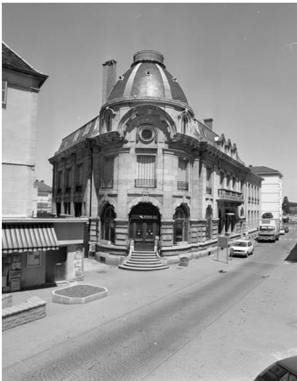
Vue d'ensemble éloignée.
