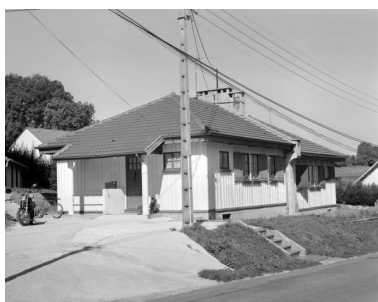
Logement double (maison Fillod). Phot. Yves Sancey IVR43_19973901401X
