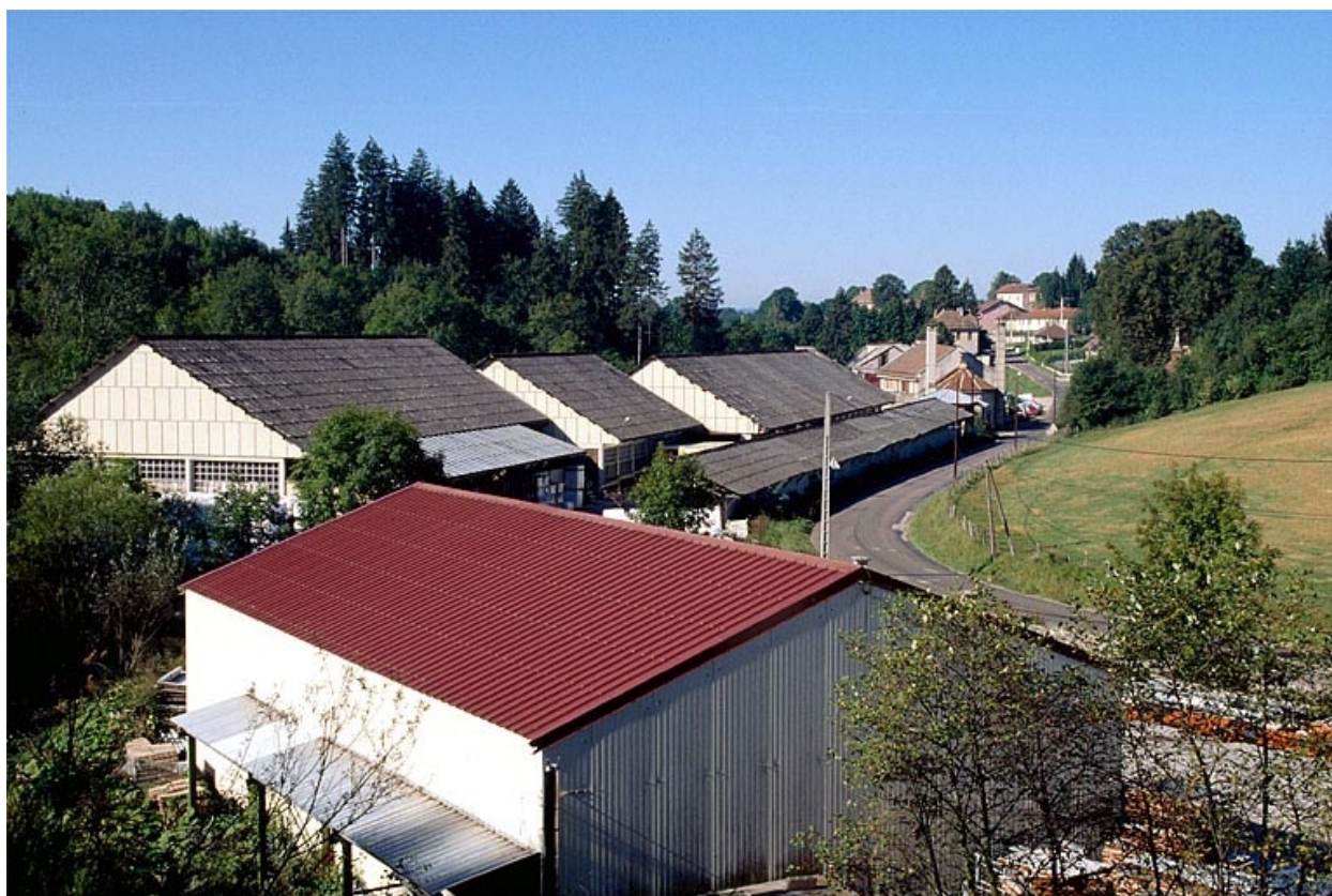
Vue d'ensemble depuis la voie ferrée.
