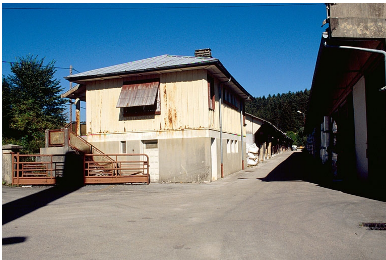
Conciergerie (maison métallique Fillod).
