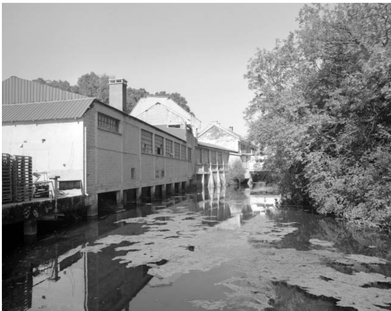
Façades des ateliers de fabrication sur l'Angillon.
