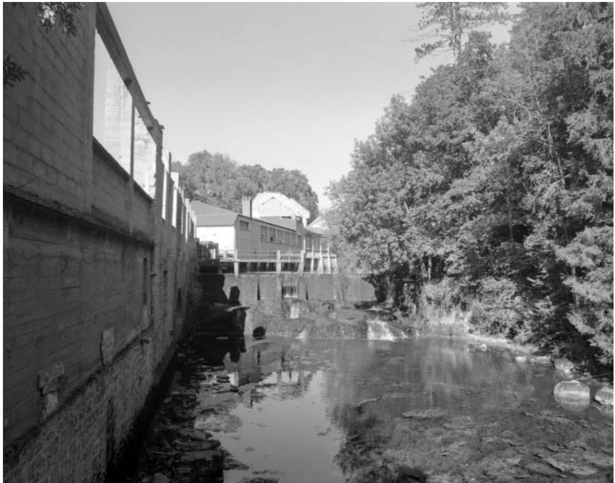
Façades de l'usine sur l'Angillon et barrage.
