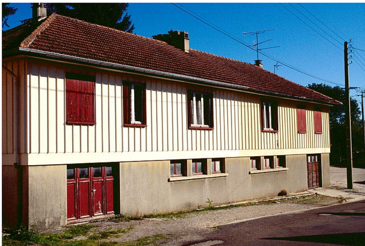
Logement double à étage (maison Fillod).
