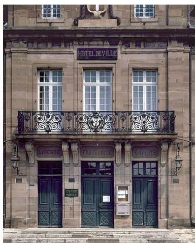
Façade principale, avant-corps central. Phot. Jérôme Mongreville IVR43_19882500061VA
