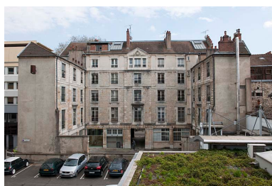
Vue d'ensemble des façades sur cour.
