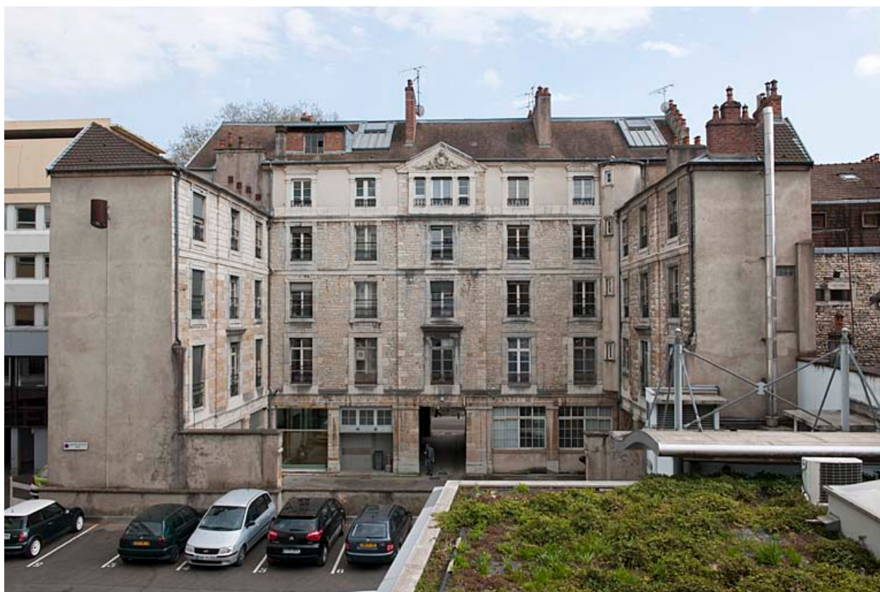
Vue d'ensemble des façades sur cour.
