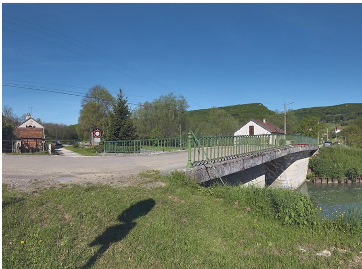
Pont sur écluse pris d'aval.
