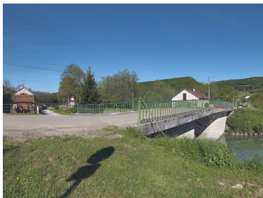
Pont sur écluse pris d'aval.
