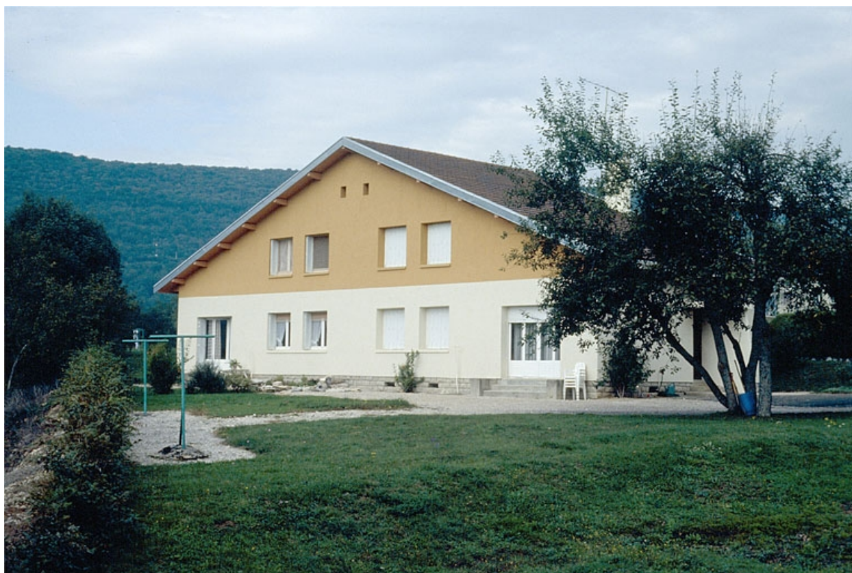
Maison d'agent de maîtrise : façade antérieure.
