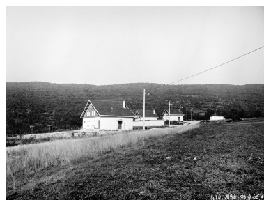
Cité de l'Exploitation à Cernon. Phot. Jérôme Mongreville, Autr. Studios Villeurbannais Monchanin et Périchon IVR43_19913900306X
