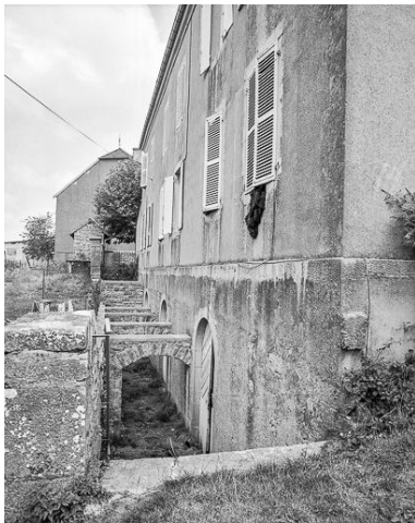
Détail du soubassement de la façade postérieure. Phot. Yves Sancey IVR43_19843900295X
