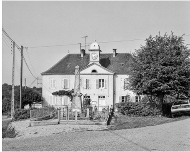
Façade antérieure vue de face. Phot. Yves Sancey IVR43_19843900292X
