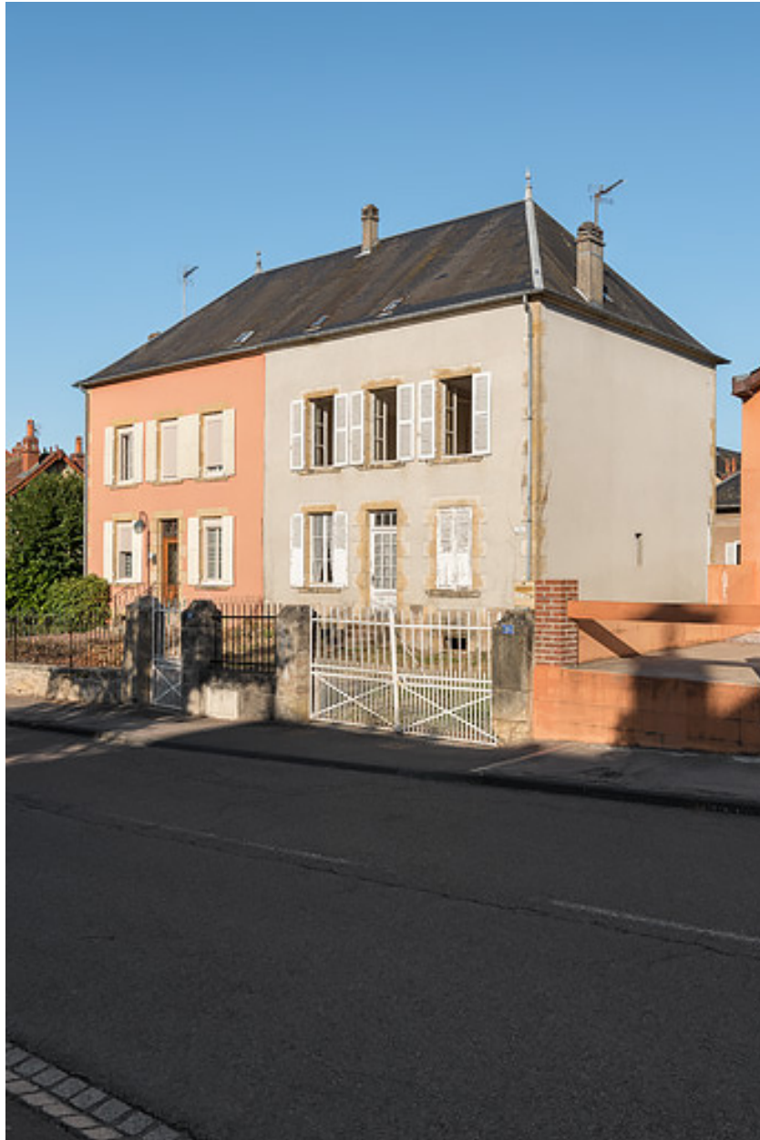
Façade sur l'actuelle avenue Eugène Collin.
