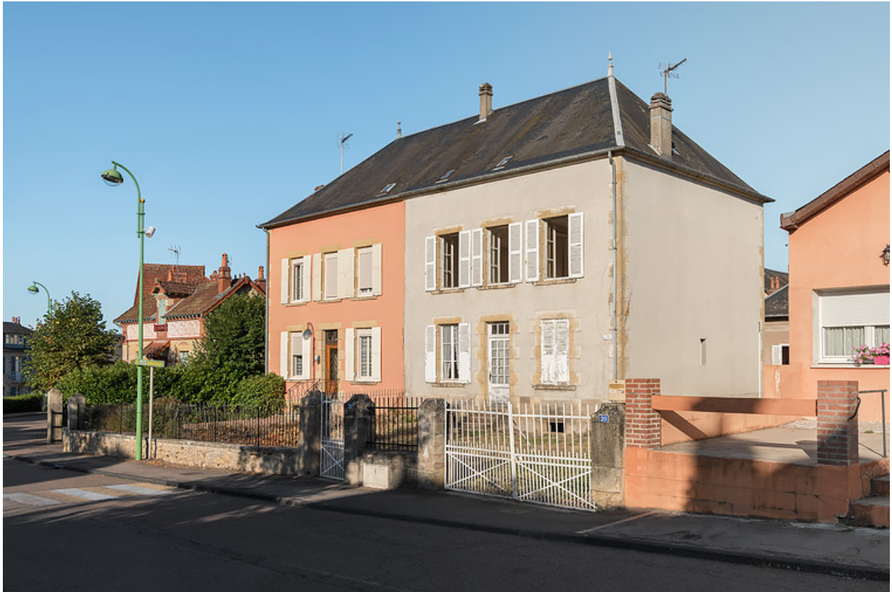
Façade sur l'actuelle avenue Eugène Collin.
