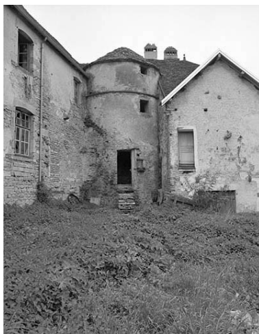
Façade ouest, partie gauche. Phot. Yves Sancey IVR43_19813900178X
