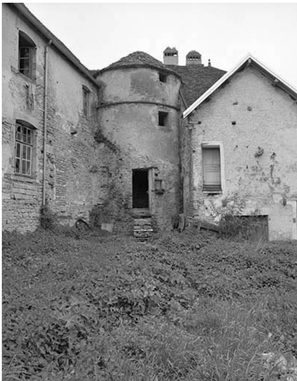
Façade ouest, partie gauche.
