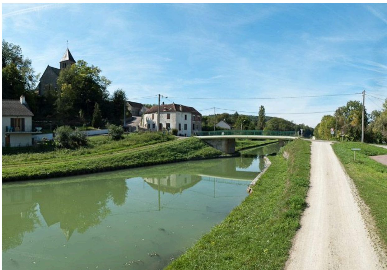
Vue du pont.
