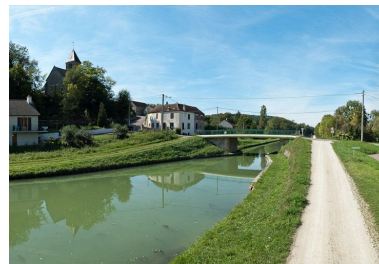
Vue du pont. Phot. Pierre-Marie Barbe-Richaud IVR26_20112104122NUC2AQ
