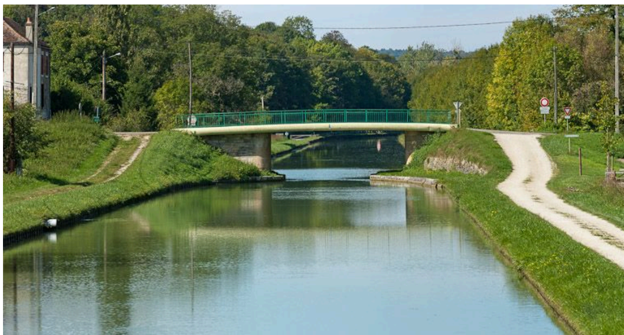
Vue du pont.
