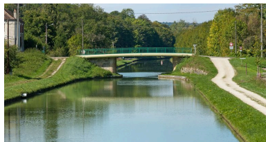
Vue du pont. Phot. Pierre-Marie Barbe-Richaud IVR26_20112104117NUC4AQ
