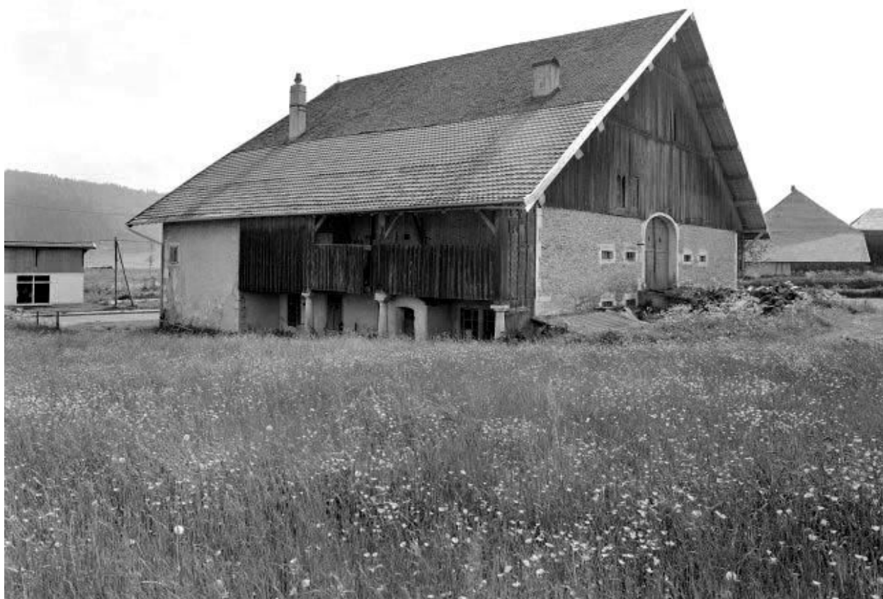
Façades postérieure et latérale droite.
