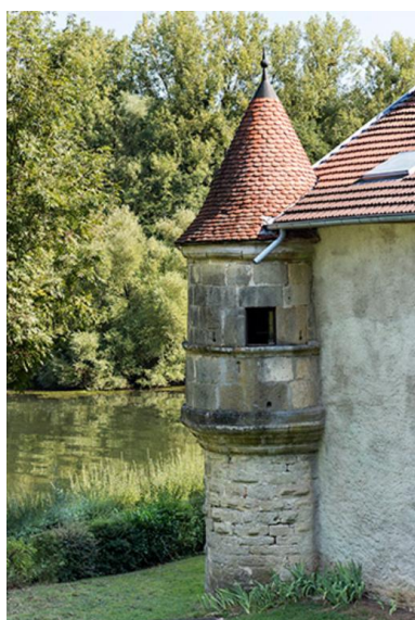
L'échauguette de l'ancienne écurie Phot. Sonia Dourlot IVR43_20167001275NUC4A
