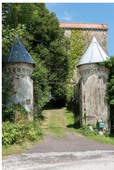
Tourelles et portail d'entrée au château. Phot. Sonia Dourlot IVR43_20167001288NUC4A
