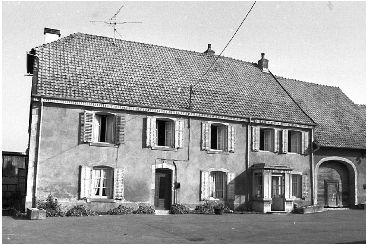
Ferme située 19 rue de Voujeaucourt (?).
