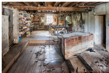
Local de la turbine et atelier d'entretien. Phot. Jérôme Mongreville IVR43_20152501884NUC4A
