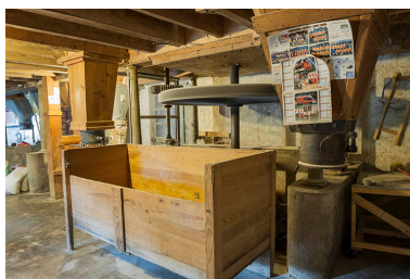
Rez-de-chaussée. Transmission par engrenages de la turbine. Phot. Jérôme Mongreville IVR43_20152501879NUC4A
