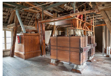
Troisième étage. Vue d'ensemble. Phot. Jérôme Mongreville IVR43_20152501864NUC4A
