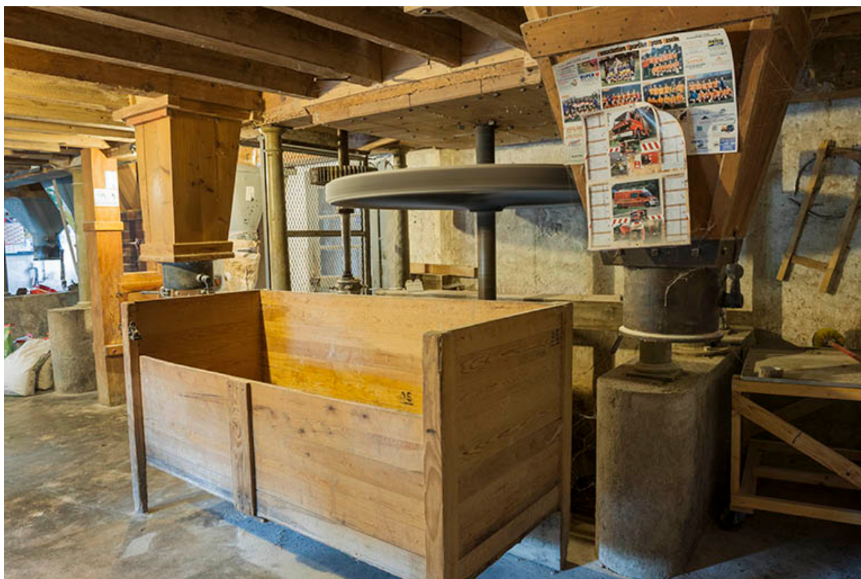
Rez-de-chaussée. Transmission par engrenages de la turbine.
