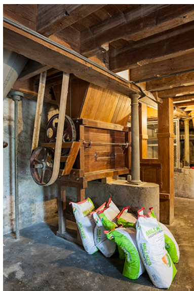
Rez-de-chaussée. Mélangeuse. Phot. Jérôme Mongreville IVR43_20152501878NUC4A
