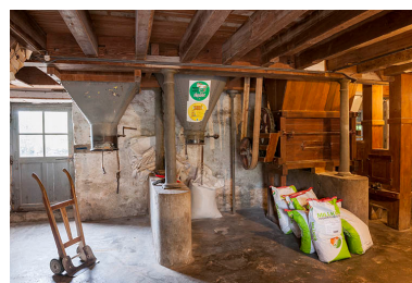
Rez-de-chaussée. Poste d'ensachage et mélangeuse. Phot. Jérôme Mongreville IVR43_20152501877NUC4A
